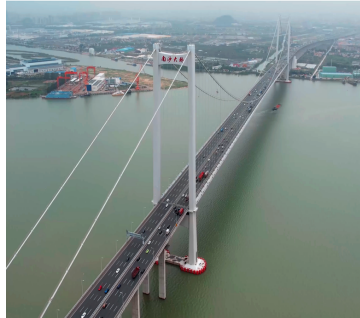
(v) Γέφυρα Nansha
