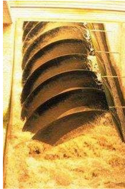
Εικόνα 6. (Αριστερά) Μια σειρά από κοχλίες του Αρχιμήδη στη μοντέρνα μορφή τους (στους οποίους ο τοίχος δεν είναι συνδεδεμένος), όπως εφαρμόστηκαν στη μονάδα επεξεργασίας λυμάτων της Αθήνας, που αντλεί 1 εκατομμύριο m^3 λυμάτων την ημέρα. (Δεξιά) Λεπτομέρεια που δείχνει έναν έλικα. (Koutsogiannis and Patrikiou 2014)
