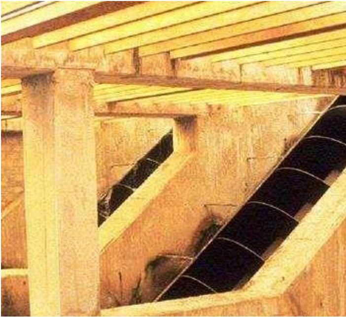
Εικόνα 6. (Αριστερά) Μια σειρά από κοχλίες του Αρχιμήδη στη μοντέρνα μορφή τους (στους οποίους ο τοίχος δεν είναι συνδεδεμένος), όπως εφαρμόστηκαν στη μονάδα επεξεργασίας λυμάτων της Αθήνας, που αντλεί 1 εκατομμύριο m^3 λυμάτων την ημέρα. (Δεξιά) Λεπτομέρεια που δείχνει έναν έλικα. (Koutsogiannis and Patrikiou 2014)
