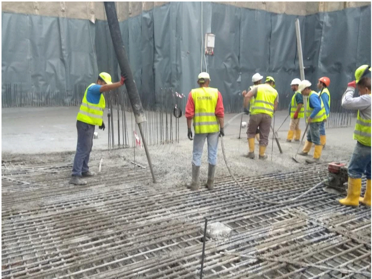
Εικόνα 3.22 - Σκυροδέτηση και δόνηση γενικής κοιτόστρωσης β'
