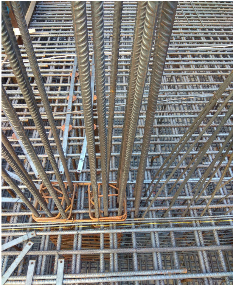
Εικόνα 3.17 - Γενική κοιτόστρωση μεγάλου πάχους
