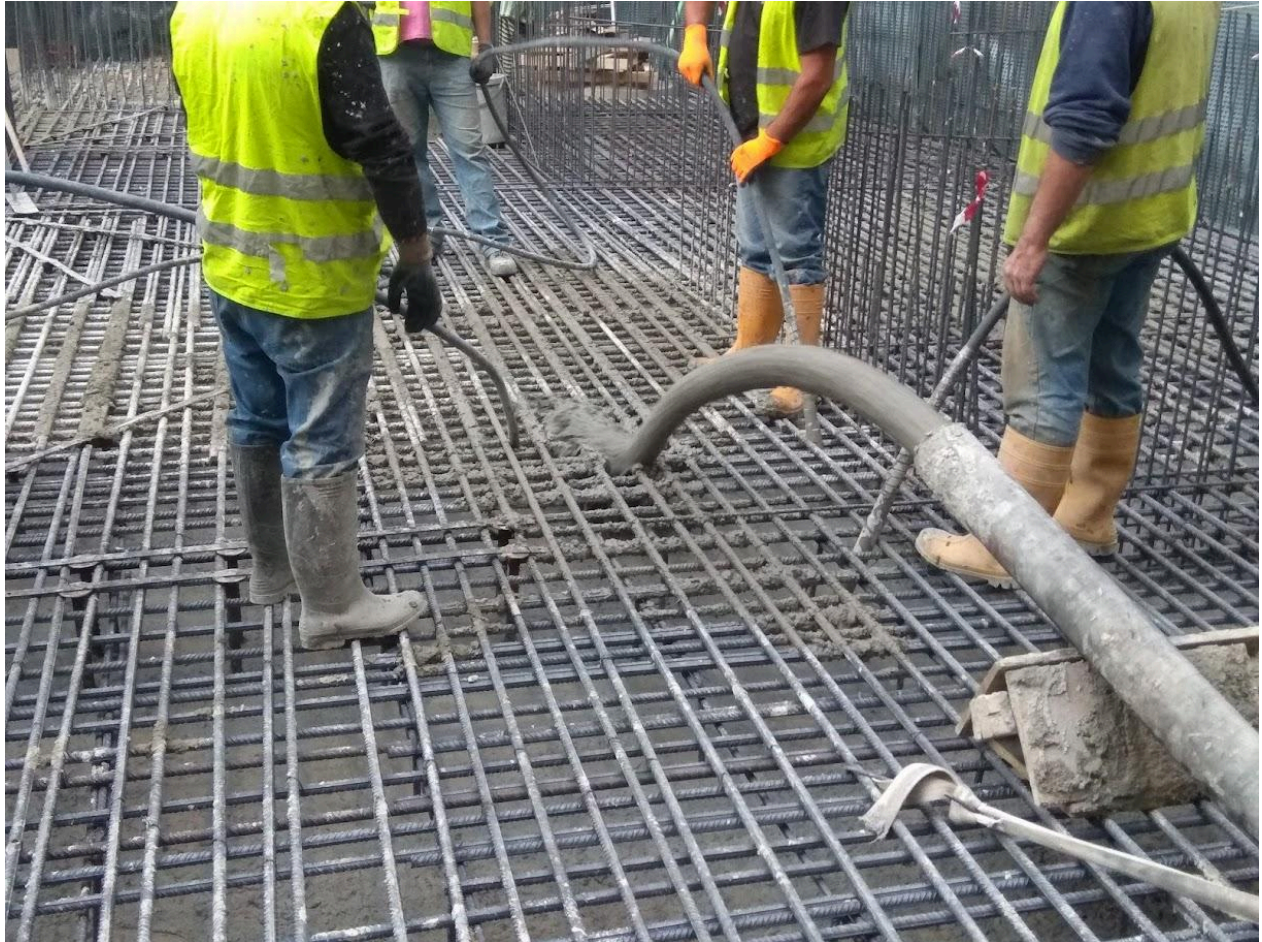
Εικόνα 3.21 - Σκυροδέτηση και δόνηση γενικής κοιτόστρωσης α'
