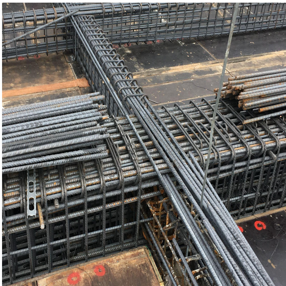
Εικόνα 4.3 - Υπερβολικά οπλισμένη δοκός
