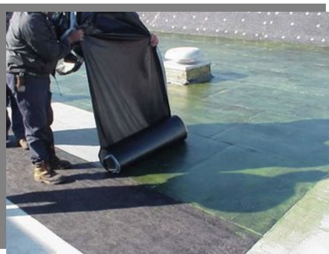
Εικόνα 36: Στεγάνωση δώματος
