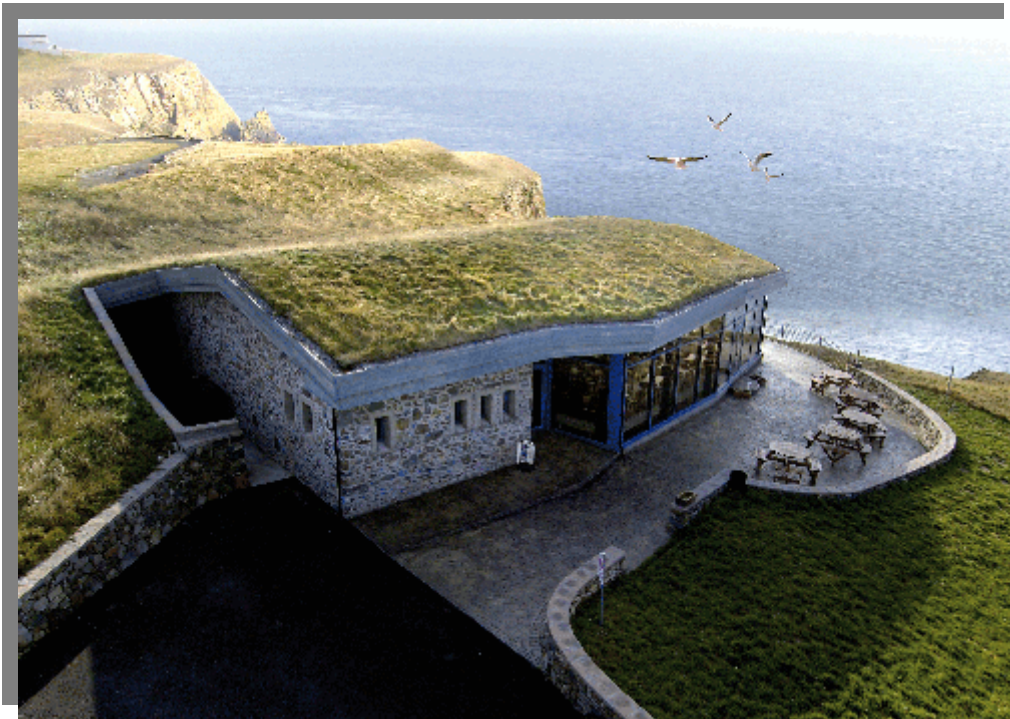
Εικόνα 29: Φυτεμένο δώμα εκτατικού τύπου
