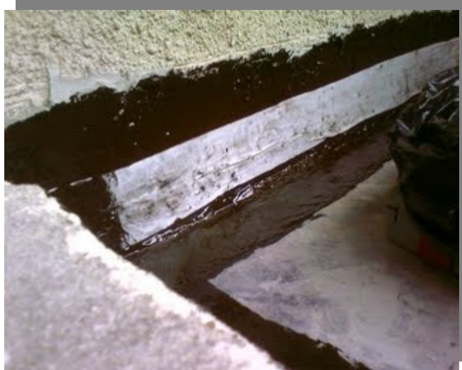
Εικόνα 37: Στεγάνωση στηθαίου
