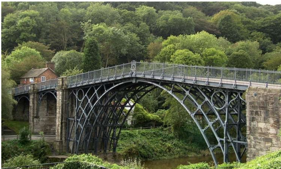
Εικόνα 1.3. Coalbrookdale Bridge, Αγγλία 1779
