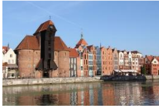
Εικόνα 1.9 Γερανός του 15 ου αι. κατασκευασμένος στο λιμάνι του Γκντανσκ της Πολωνίας για την τοποθέτηση καταρτιών [Πηγή: Πολωνικό Εθνικό Ναυτικό Μουσείο]
