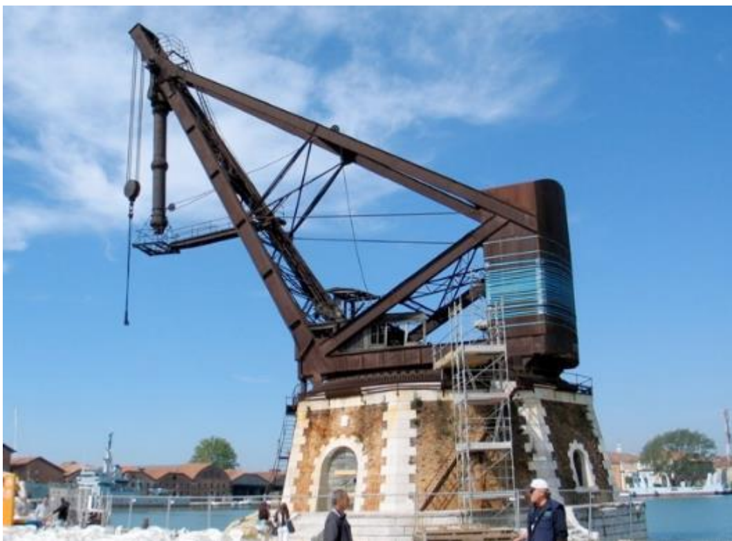
Εικόνα 1.11 Ο μοναδικός σωζόμενος υδραυλικός γερανός του Armstrong στη Βενετία κατασκευασμένος της δεκαετία του 1880 [Πηγή: Venice in Peril]
