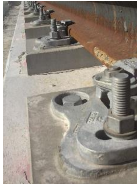
Εικόνα 1.30 Ολοκληρωμένο σύστημα υποδομής-επιδομής κατασκευασμένο σε τσιμεντένια πλάκα άνευ θεμελίωσης [Πηγή: Gantrex]
