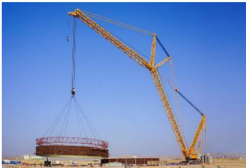
Εικόνα 1.22 Ερπυστριοφόρος γερανός της Liebherr με μέγιστη χωρητικότητα φορτίου τους 3000 τόνους κατά την χρήση του σε εργοτάξιο (στο κάτω δεξιά μέρος της εικόνας είναι εμφανή τα αντίβαρα τα οποία απαιτούνται για την εξισορρόπηση του φορτίου) [Πηγή: Liebherr]
