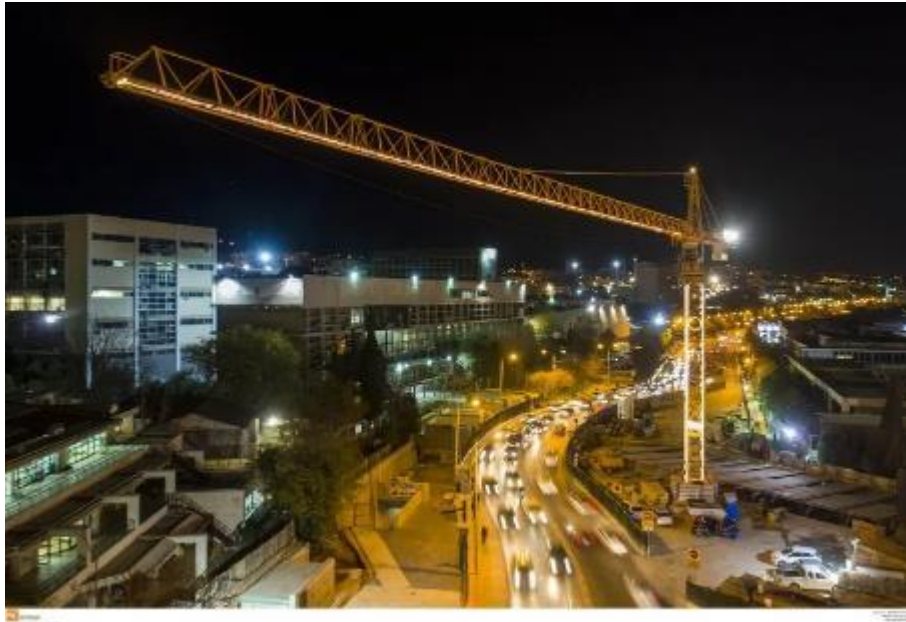
Εικόνα 1.15 Γερανός τύπου πύργος σε εργοτάξιο του μετρό της Θεσσαλονίκης [Πηγή: iefimerida]
