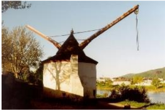
Εικόνα 1.8 Περιστροφικός γερανός κατασκευασμένος το 1413 στο λιμάνι του Τριρ της Γερμανίας [Πηγή: Stefan Kühn – Wikimedia Commons]
