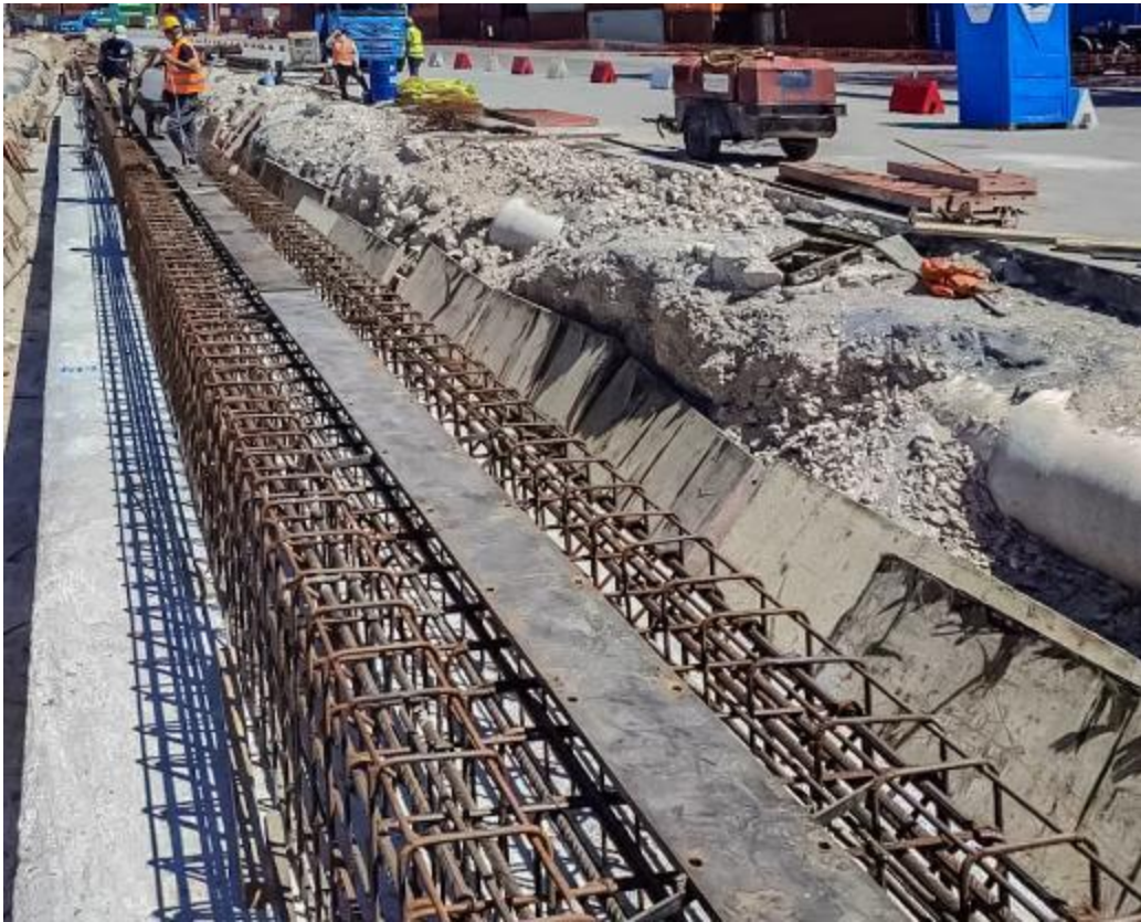
Εικόνα 1.28 Στιγμιότυπο από τις εργασίες επέκτασης υφιστάμενης υποδομής για γερανογέφυρες στην προβλήτα 2 του ΟΛΠ
