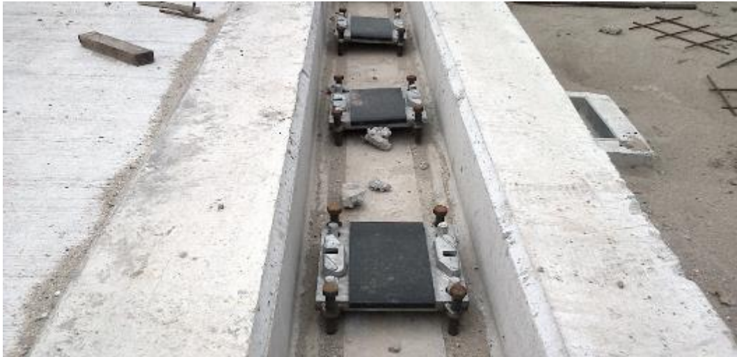
Εικόνα 1.36 Δοκοί στήριξης μετά τον εγκιβωτισμό τους [Πηγή: Gantrex]
