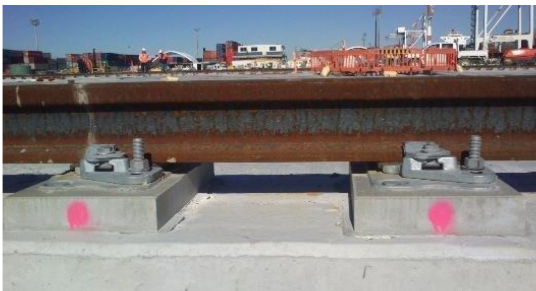
Εικόνα 1.38 Εγκιβωτισμένοι τσιμεντένιοι στρωτήρες [Πηγή: Gantrex]
