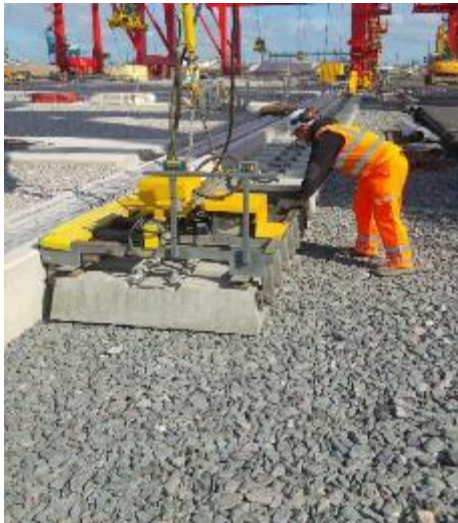
Εικόνα 1.31 Τοποθέτηση στρωτήρων με ειδικό μηχανήμα στο λιμάνι του Λίβερπουλ [Πηγή: Bemo Rail]
