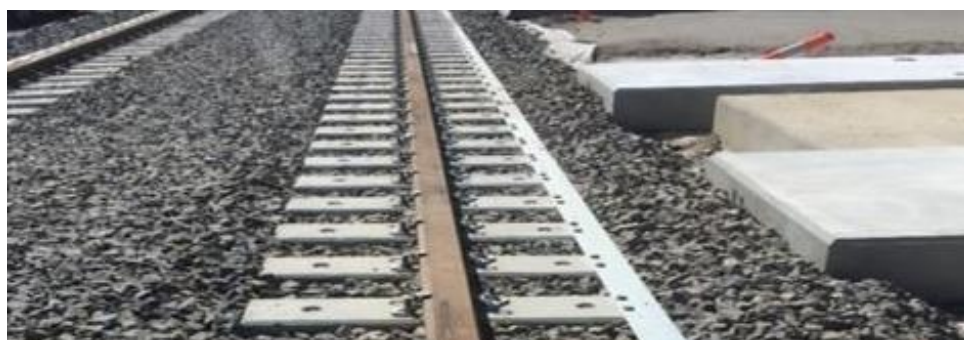
Εικόνα 1.39 Στρωτήρες επί σκόρου [Πηγή: Gantrex]
