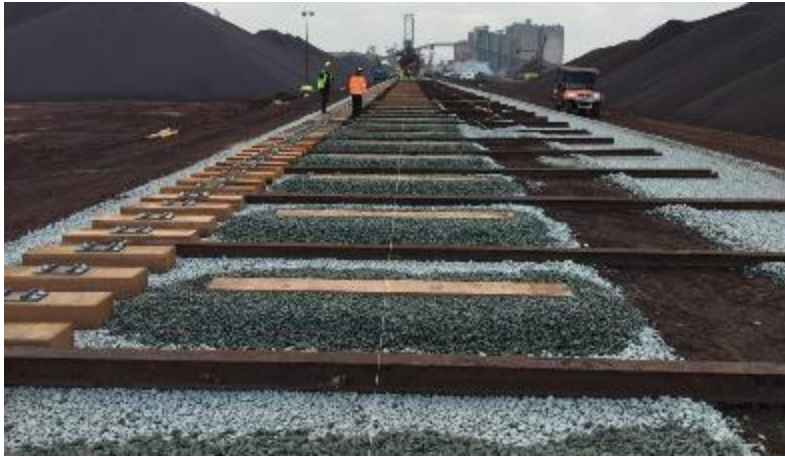
Εικόνα 1.33 Εργασίες κατασκευής γερανογέφυρας με χρήση ξύλινων στρωτήρων επί σκύρων στο λιμάνι του Ρότερνταμ [Πηγή: Bemo Rail]
