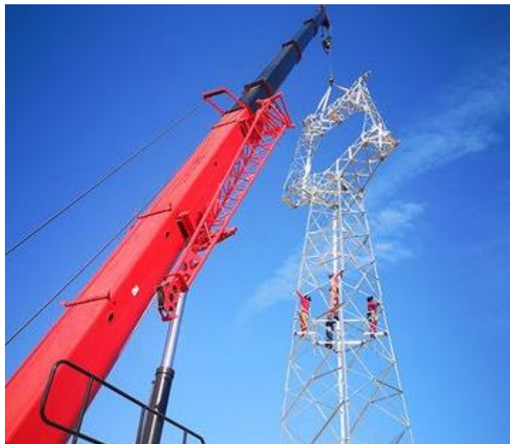
Εικόνα 1.16 Τηλεσκοπικός γερανός κατά την διάρκεια ανύψωσης πυλώνα υψηλής τάσης [Πηγή: Globalsource]
