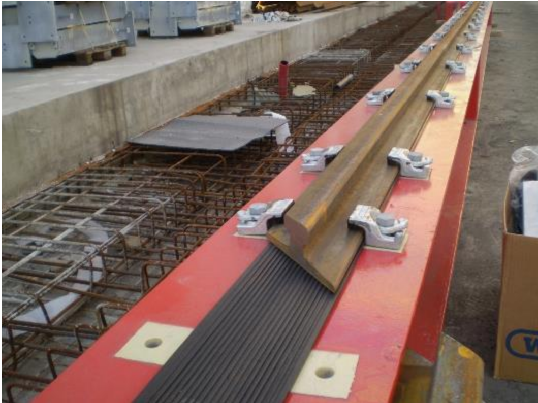
Εικόνα 1.35 Υπό κατασκευή γραμμή συνεχούς στήριξης με ελαστικό υπόθεμα [Πηγή: Gantrex]
