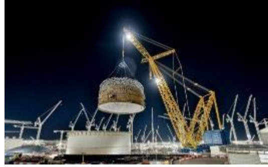
Εικόνα 1.14 Ο Sarens SGC-250 κατά την μεταφορά φορτίου βάρους 575 τόνων [Πηγή: Sarens]
