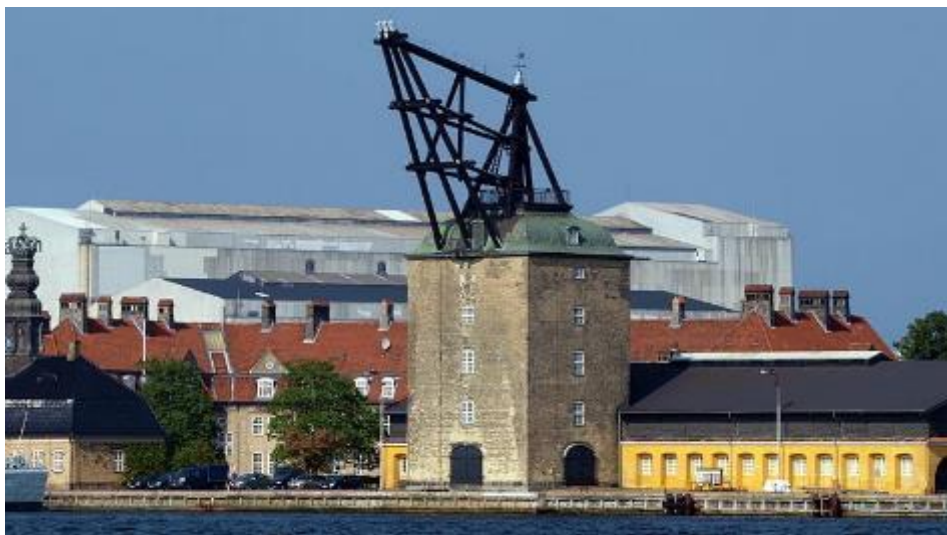
Εικόνα 1.10 Γερανός του 1742 στο λιμάνι της Κοπεγχάγης στην Δανία που χρησιμοποιούταν για την τοποθέτηση καταρτιών [Πηγή: Alf van Beem – Wikimedia Commons]
