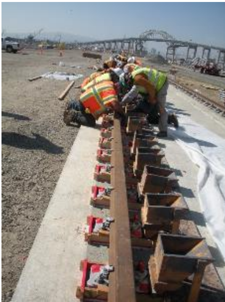
Εικόνα 1.29 Γραμμή κατά το τελικό στάδιο σκυροδέτησης των στηριγμάτων [Πηγή: Gantrex]
