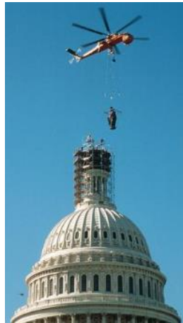
Εικόνα 1.27 Στιγμιότυπο από την διαδικασία μεταφοράς του αγάλματος από το S-64 Aircrane [Πηγή: Αρχεία Ινστιτούτου Smithsonian]
