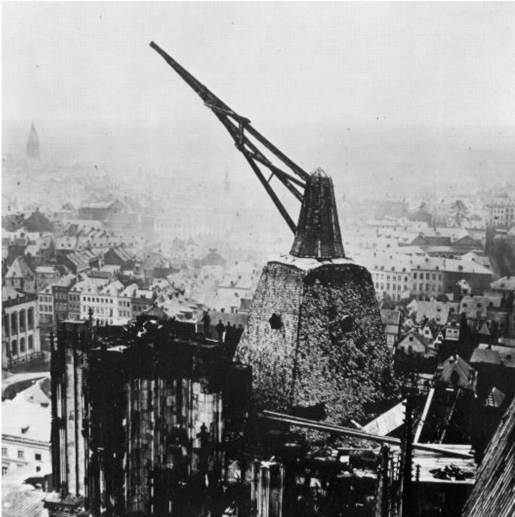
Εικόνα 1.7 Φωτογραφία του 1868 που απεικονίζει τον γερανό του 15 ου αι. που βρίσκεται στην οροφή του, τότε υπό κατασκευή, καθεδρικού ναού της Κολωνίας στην Γερμανία [Πηγή: Theodor Creifelds μέσω του Zeno.org]
