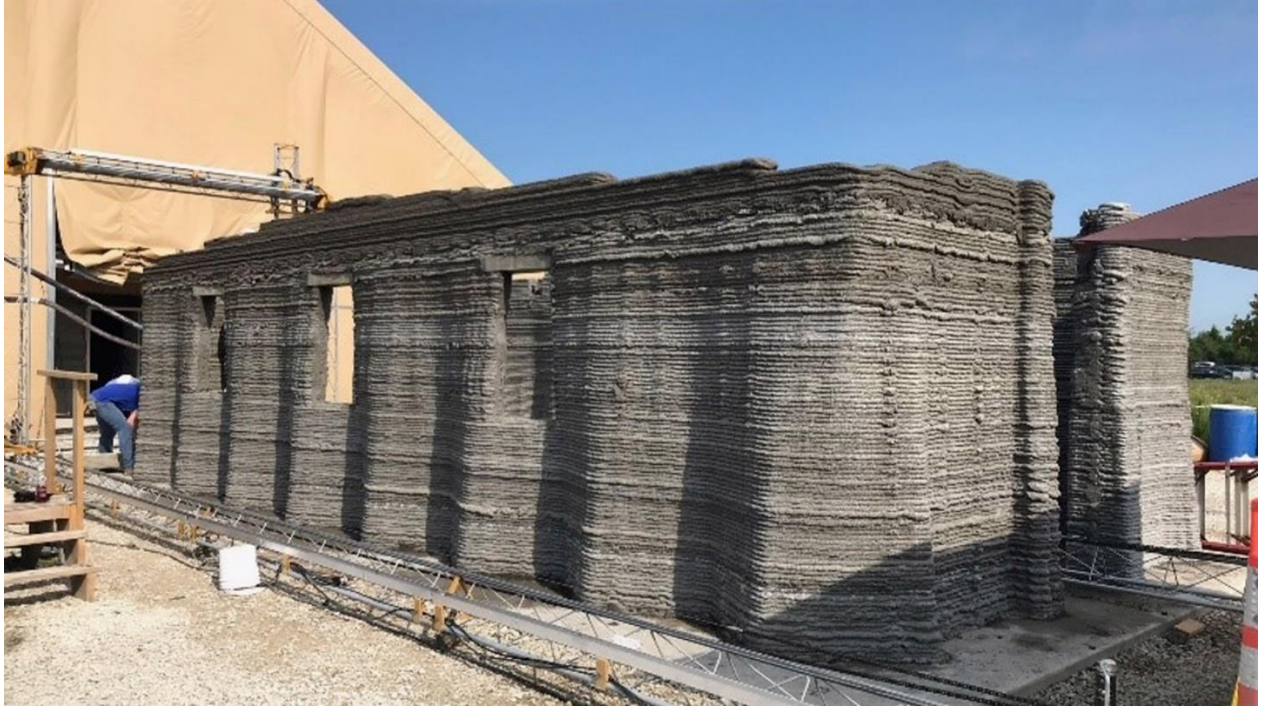
Εικόνα 23: Σύστημα τύπου γερανογέφυρας σε ράγες
