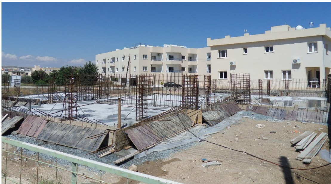
Εικόνα 4.13: Ενιαίο πέδιλο ή πεδιλόπλακα τυπικής διώροφης κατοικίας πάχους 50 εκ.
