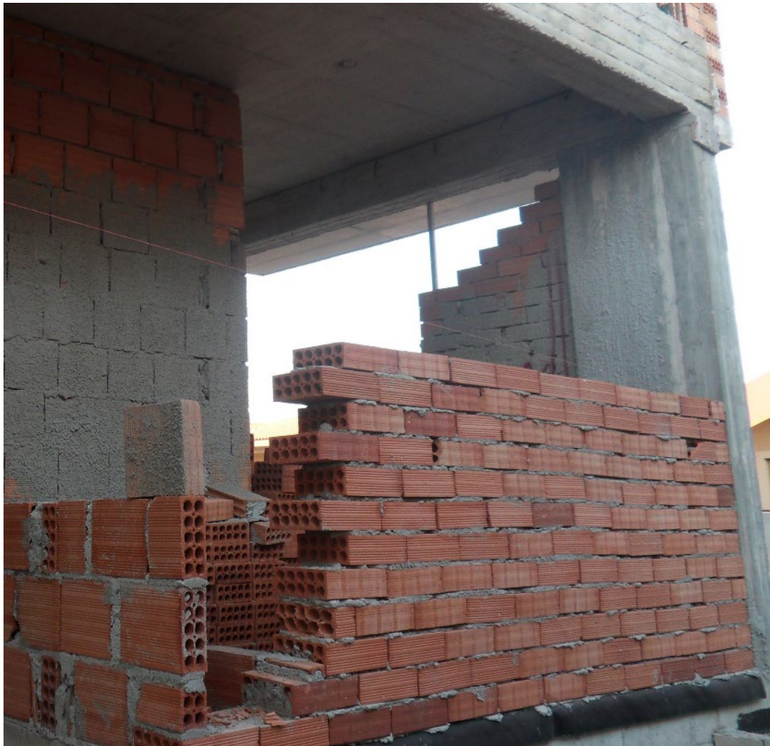
Εικόνα 2.8: Στα δεξιά φαίνεται εξωτερική τοιχοποιία κτισμένη με “ξαπλωτό” τούβλο πλάτους 25 εκατοστών και από πάνω της διακρίνεται δοκός πλάτους, επίσης, 25 εκατοστών. Κάθετα προς αυτόν διακρίνεται τοιχοποιία εσωτερική, πλάτους 10 εκατοστών.
