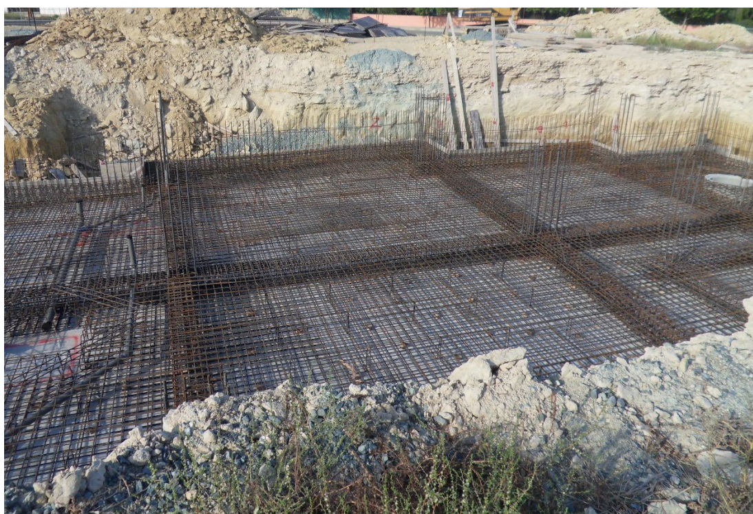
Εικόνα 4.9: Θεμελίωση υπογείου με ενιαίο πέδιλο όπου διακρίνονται και οι συνδετήριες δοκοί που συνδέουν τα θεμέλια των υποστυλωμάτων μεταξύ τους.
