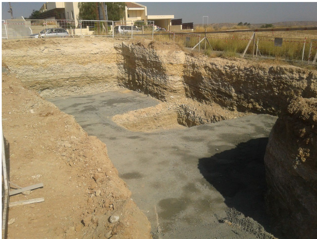
Εικόνα 4.10: Διάστρωση εδαφικών υλικών από διαβαθμισμένα σκύρα τα οποία βρέχονται και συμπιέζονται με δονητικό κύλινδρο για τη δημιουργία ισχυρής βάσης για την πεδιλόπλακα.
