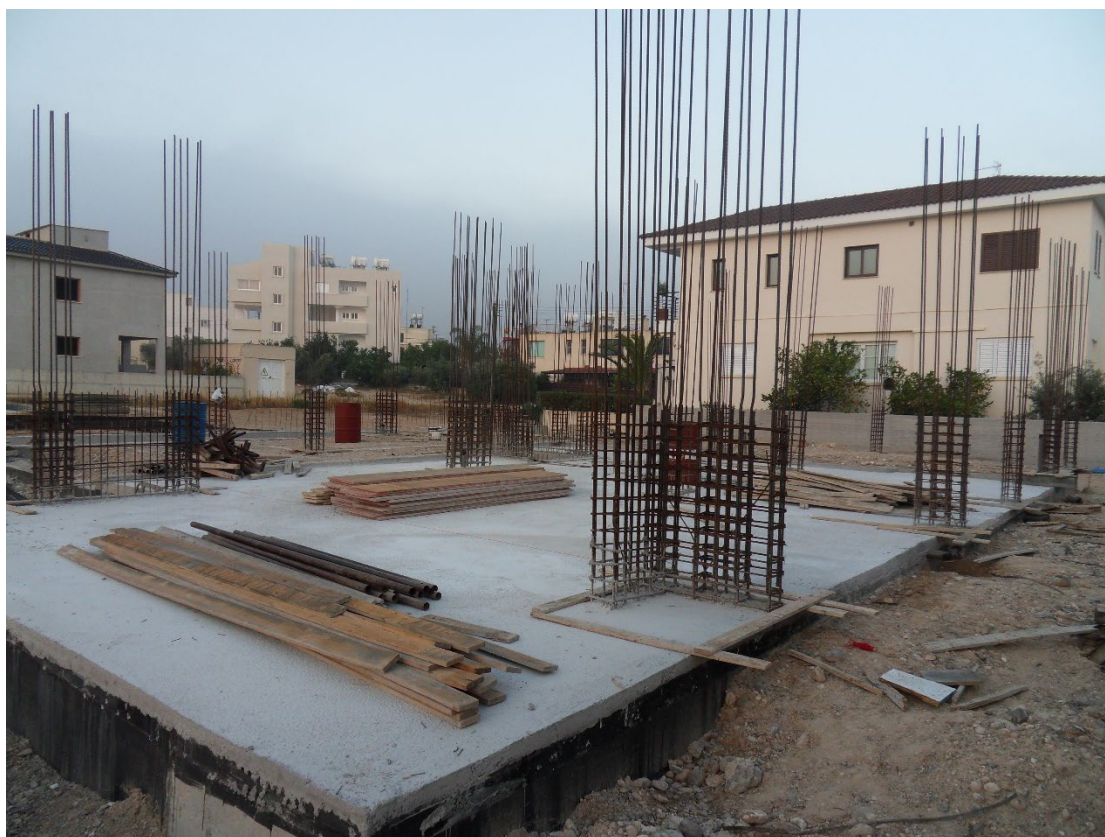
Εικόνα 4.8: Ολοκλήρωση σκυροδέτησης πατώματος ισογείου αφού προηγουμένως έχει προηγηθεί υγρομόνωση και τοποθέτηση οπλισμού επί της επιχωμάτωσης των φερόντων στοιχείων της θεμελίωσης
