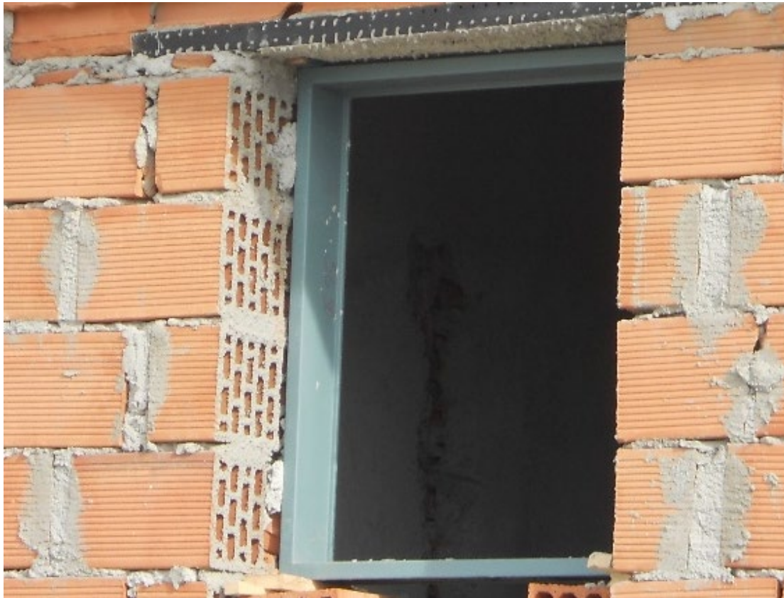
Εικόνα 2.12: Εξωτερική τοιχοποιία της κατασκευής, με τα ειδικά θερμομονωτικά τούβλα (διακρίνονται στο πάχος του τοίχου / παρειά ανοίγματος).
