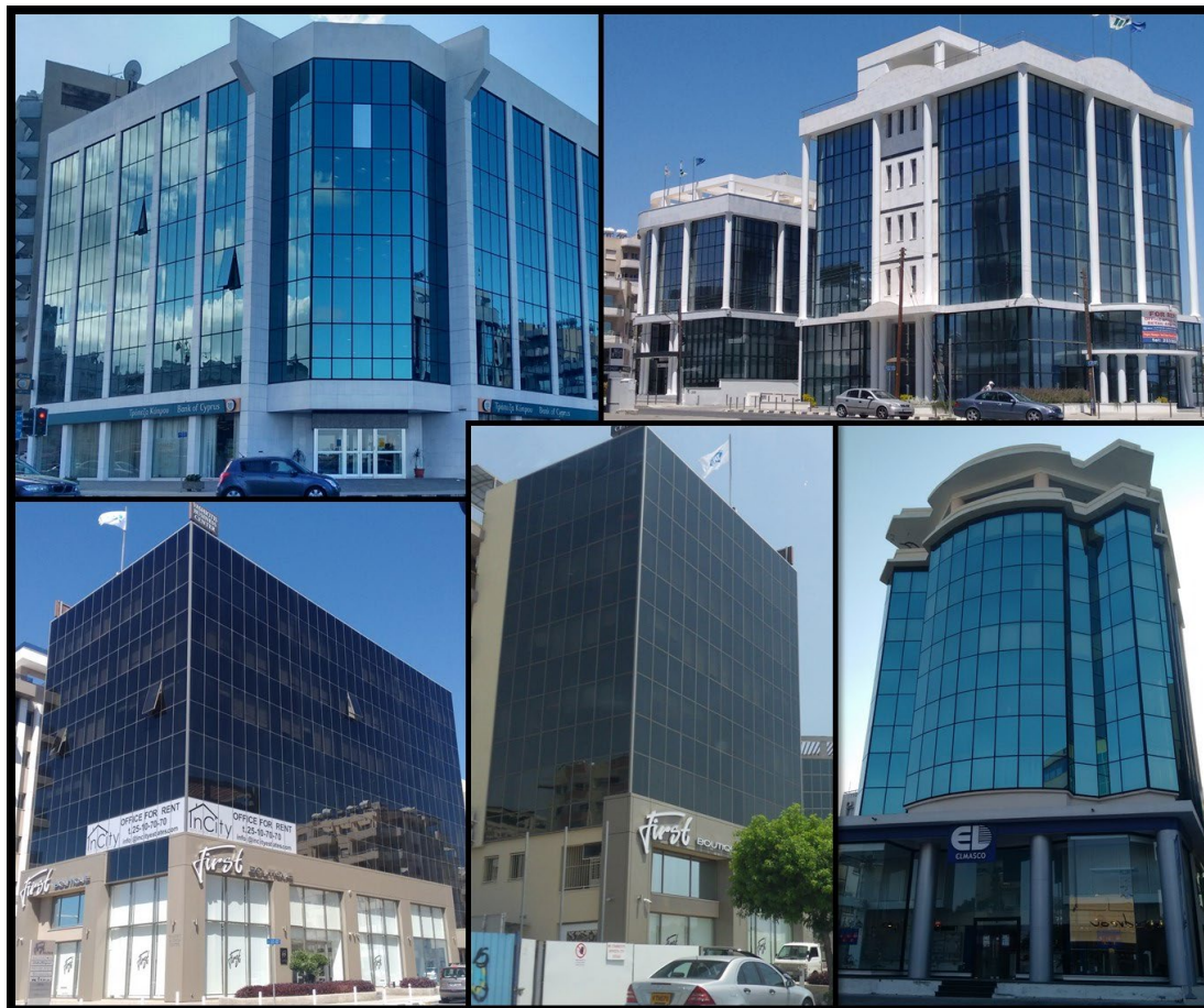
Εικόνα 2.1: Εμπορικά κτίρια στη Κύπρο με όψεις εξ' ολοκλήρου από υαλοπίνακες χωρίς καμία πρόνοια σκιασμού.
