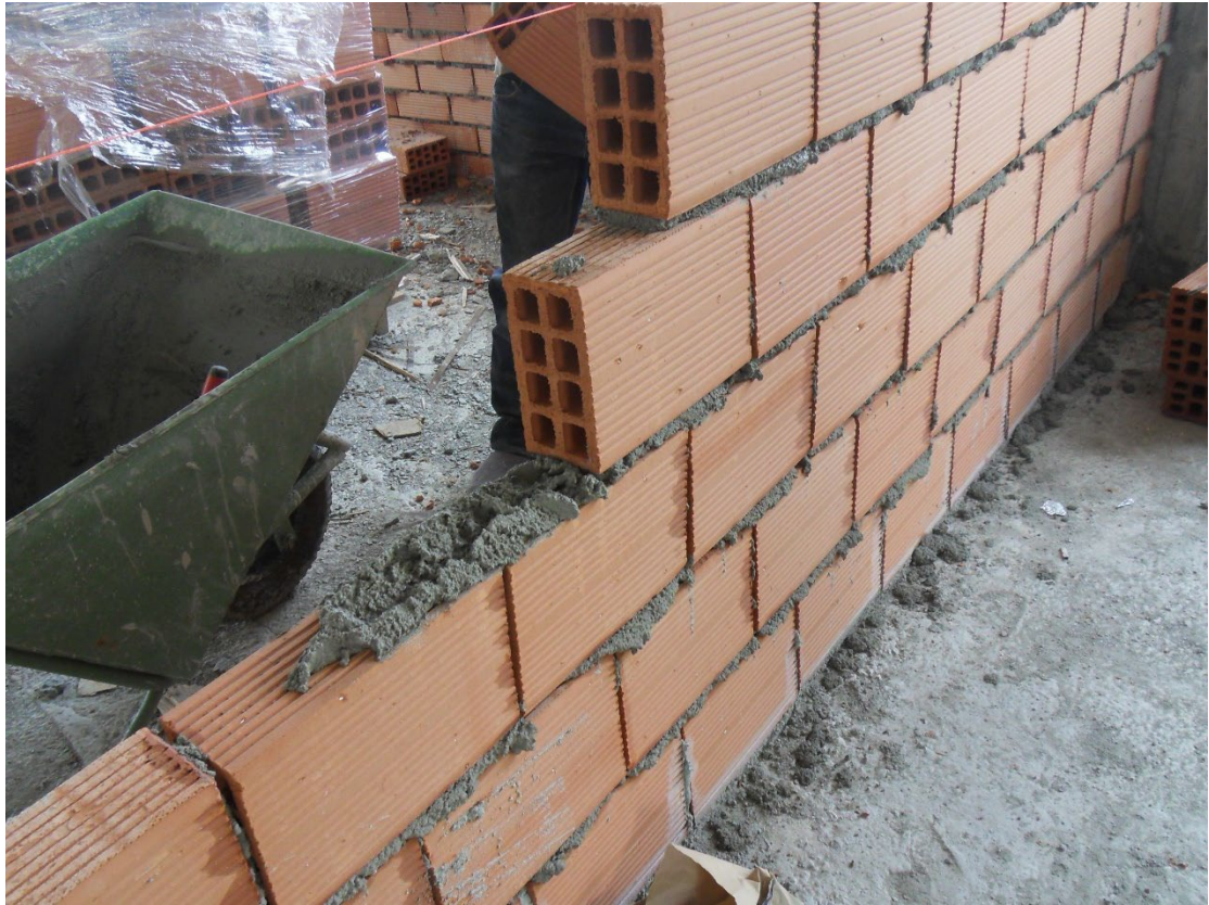
Εικόνα 4.21: Κτίσιμο μεσοτοιχίας με συνδετική κονία και όρθια κτισμένα τα τούβλα.
