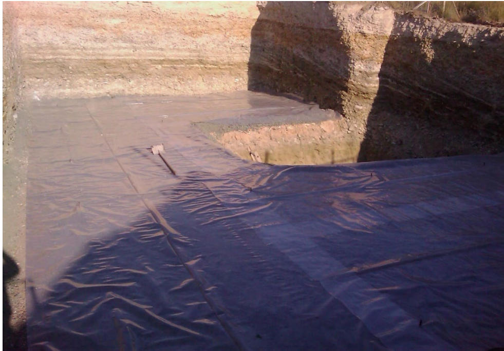
Εικόνα 4.11: Τοποθέτηση φύλλου πολυαιθυλενίου πάνω από την λιθόστρωση.
