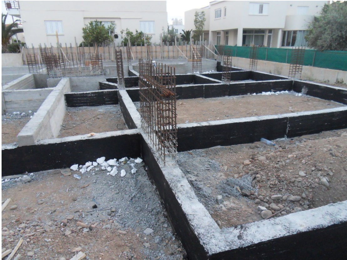
Εικόνα 4.5 Συνδετήριες δοκοί πεδίων, που έχουν υδρομονωθεί με ασφαλτοειδείς βαφές.
