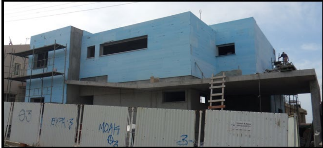
Εικόνες 2.24: Εξωτερικοί τοίχοι πλήρωσης κτισμένοι με Κυπριακό τυπικό τούβλο: α) στο πλάτος των φερόντων στοιχείων (πάνω), β) με εξωτερικό επίχρισμα (μέση) και γ) όταν στο τέλος όλες οι εξωτερικές επιφάνειες καλύπτονται με θερμομονωτικές πλάκες (κάτω).
