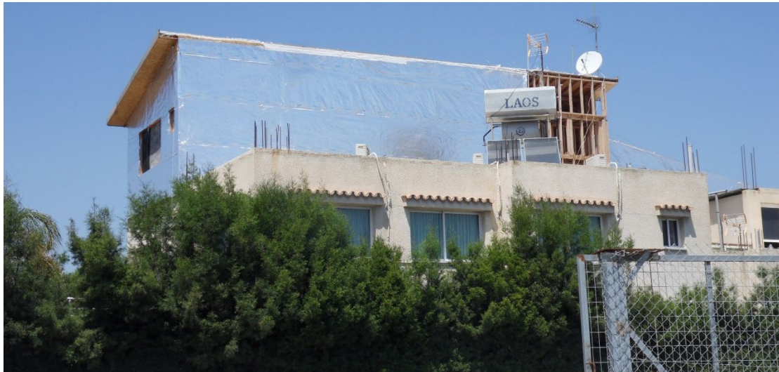
Εικόνα 1.2: Τοποθέτηση ανακλαστικού υλικού για αποκοπή της μετάδοσης της θερμότητας, μέσω ακτινοβολίας, εντός εξωτερικής τοιχοποιίας από ξηρά δόμηση.
