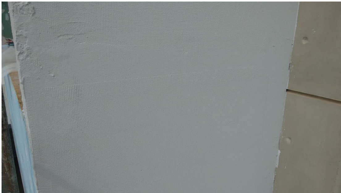
Εικόνα 2.15: Εξωτερικό επίχρισμα θερμομονωτικών πλακών από δύο χέρια σπάτουλας και πλαστικό δίκτυ.
