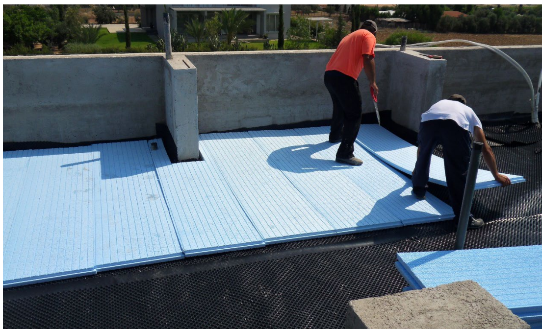
Εικόνα 2.25: Τοποθέτηση θερμομονωτικών πλακών επί πλάκας οροφής, πάνω από φράγμα υδρατμών.
