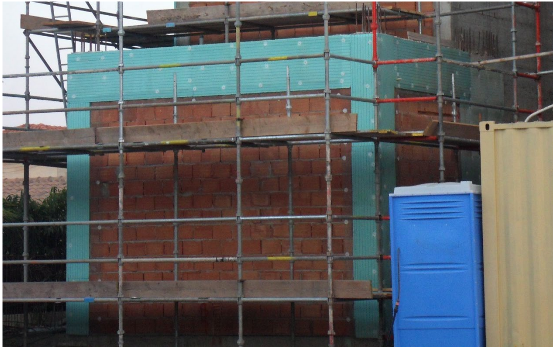
Εικόνα 2.14: Κατοικία με φέροντα οργανισμό από οπλισμένο σκυρόδεμα, ο οποίος έχει θερμομονωθεί με πλάκες εξηλασμένης πολυστερίνης. Διακρίνεται το στερέωμά του με πλατυκέφαλα καρφιά.
