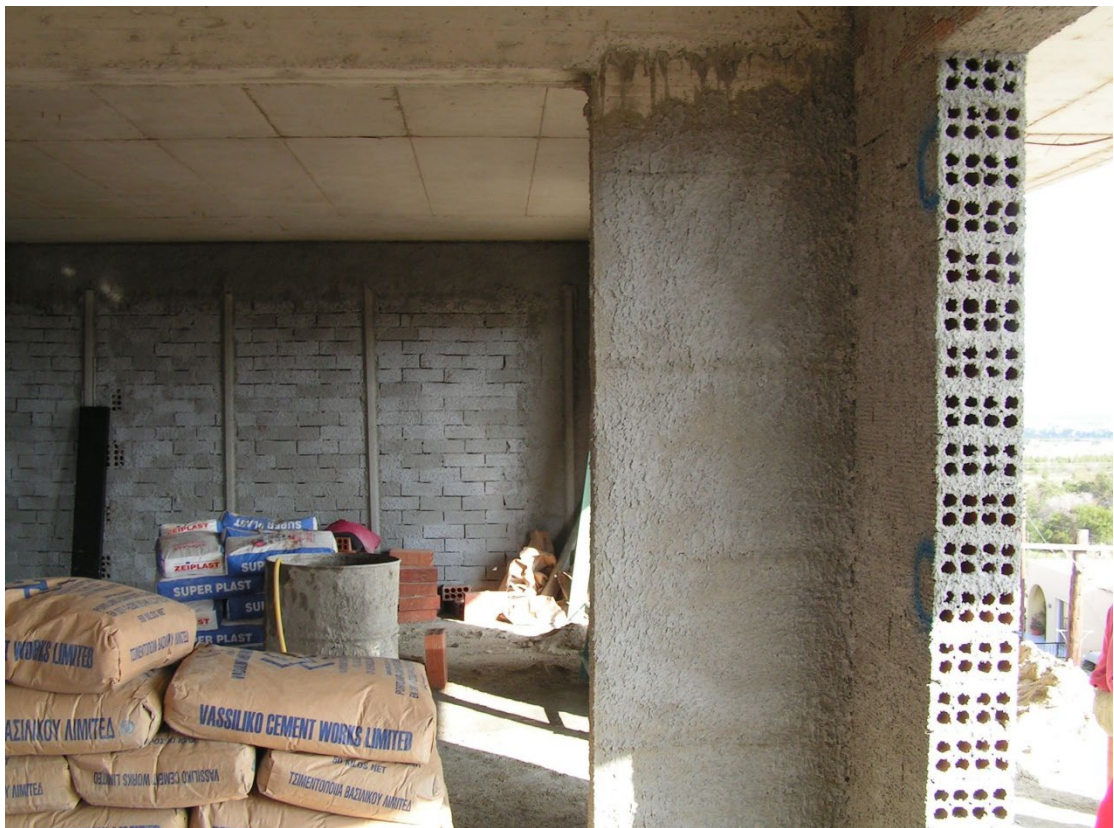
Εικόνα 4.22: Εξωτερικός τοίχος πλήρωσης από τυπικό τούβλο πάχους 20 εκ. κτισμένος κάτω από δοκάρι πλάτους, επίσης, 20 εκ.
