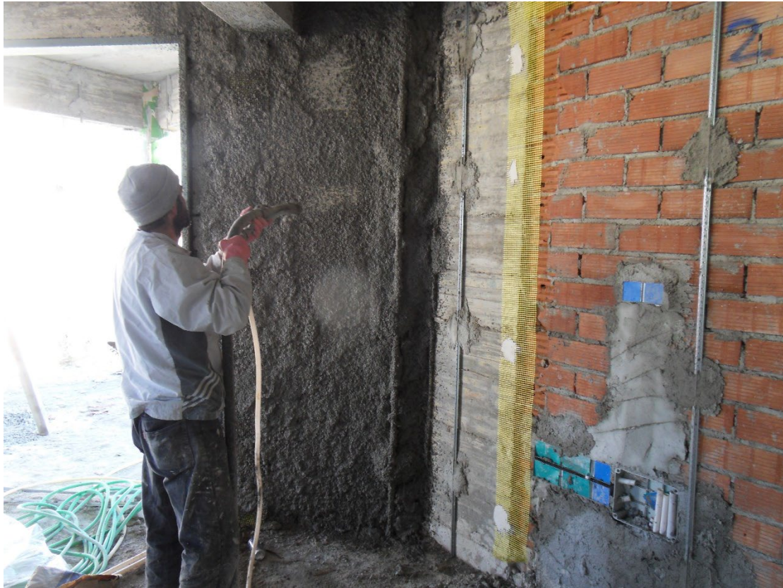
Εικόνα 2.17: Ψεκασμός θερμοσοβά από εξειδικευμένο συνεργείο, στην επιφάνεια του μπετόν και του τούβλου. Διακρίνονται οι μεταλλικοί οδηγοί στην επιφάνεια που χρειάζεται να σοβατιστεί.
