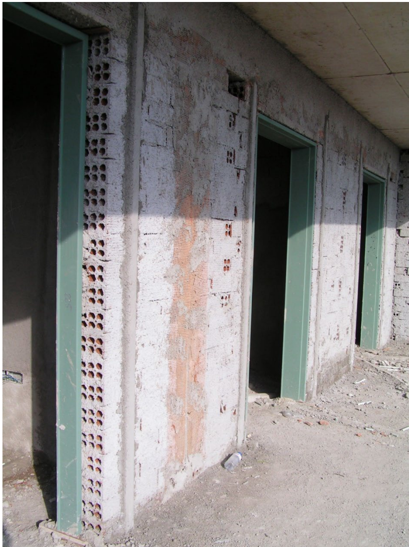
Εικόνα 2.7: Εξωτερική δομική τοιχοποιία κτισμένη με το τυπικό τούβλο “ξαπλωτό” δημιουργώντας εξωτερικές τοιχοποιίες πλάτους 20 εκατοστών (25 εκατοστά με τα επιχρίσματα)
