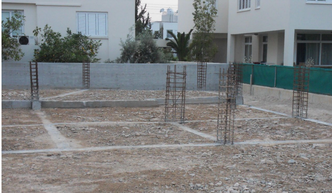
Εικόνα 4.6: Επιχωμάτωση με λιθόστρωση στο ύψος της πάνω πλευράς των πεδιλοδοκών.
