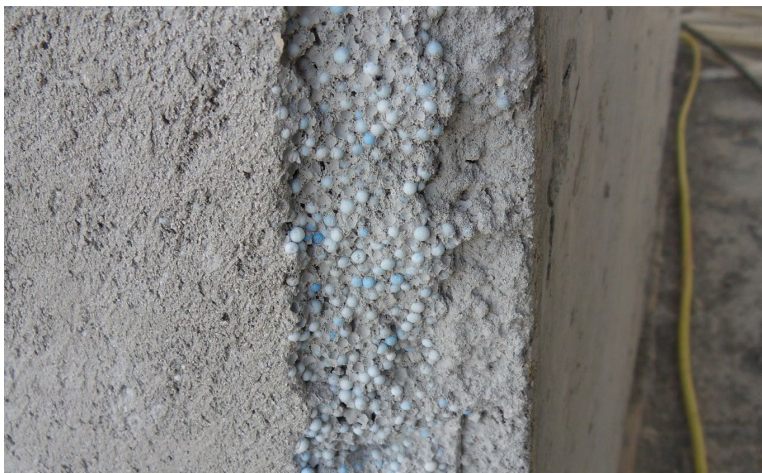
Εικόνα 2.16: Εξωτερικό επιχρίσματα από τσιμεντοειδή κονίαμα που περιέχει μέσα κόκκους από διογκωμένη πολυστερίνη.
