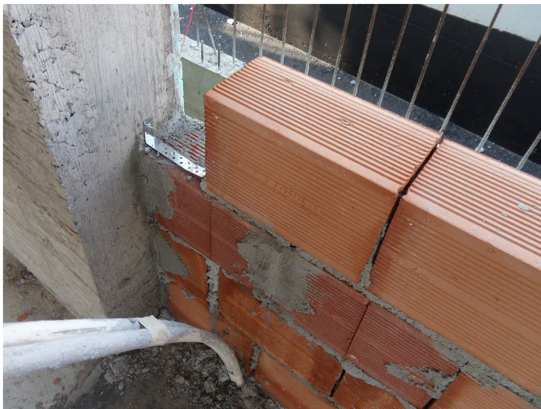
Εικόνα 2.3: Μεταλλική γωνία στερεωμένη στο υποστύλωμα, έτοιμη να κτιστεί εντός της τοιχοποιίας, για την καλύτερη σύνδεση της με το φέρων στοιχείο της κατασκευής.
