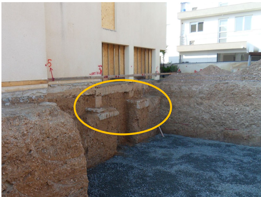
Εικόνα 4.4: Κοντοί στύλλοι ή υποκόλωνα σε κατασκευή της δεκαετίας του '80, τα οποία αποκαλύφθηκαν κατά τη διάρκεια εκσκαφής υπογείου γειτονικής, εφαπτόμενης, οικοδομής.
