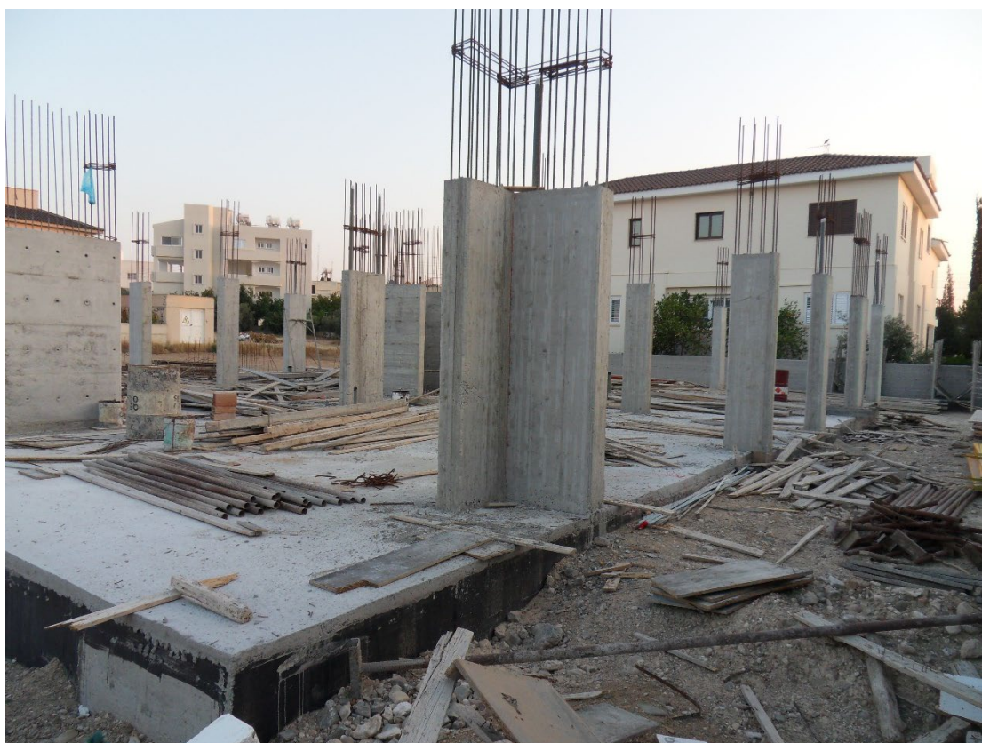
Εικόνα 4.17: Αφαίρεση καλουπιών των κολώνων ισογείου μετά την σκυροδέτησή τους.
