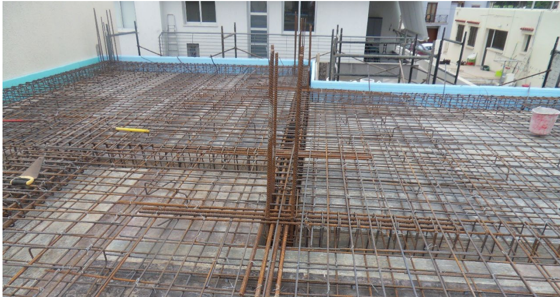
Εικόνα 4.15: Πλάκα οροφής ισογείου έτοιμη για σκυροδέτηση, όπου διακρίνεται οπλισμός των κολώνων ισογείου που σταματά στο κατάλληλο μήκος πάνω από την πλάκα για να μπορεί να τοποθετηθεί ο οπλισμός των κολώνων του ορόφου.
