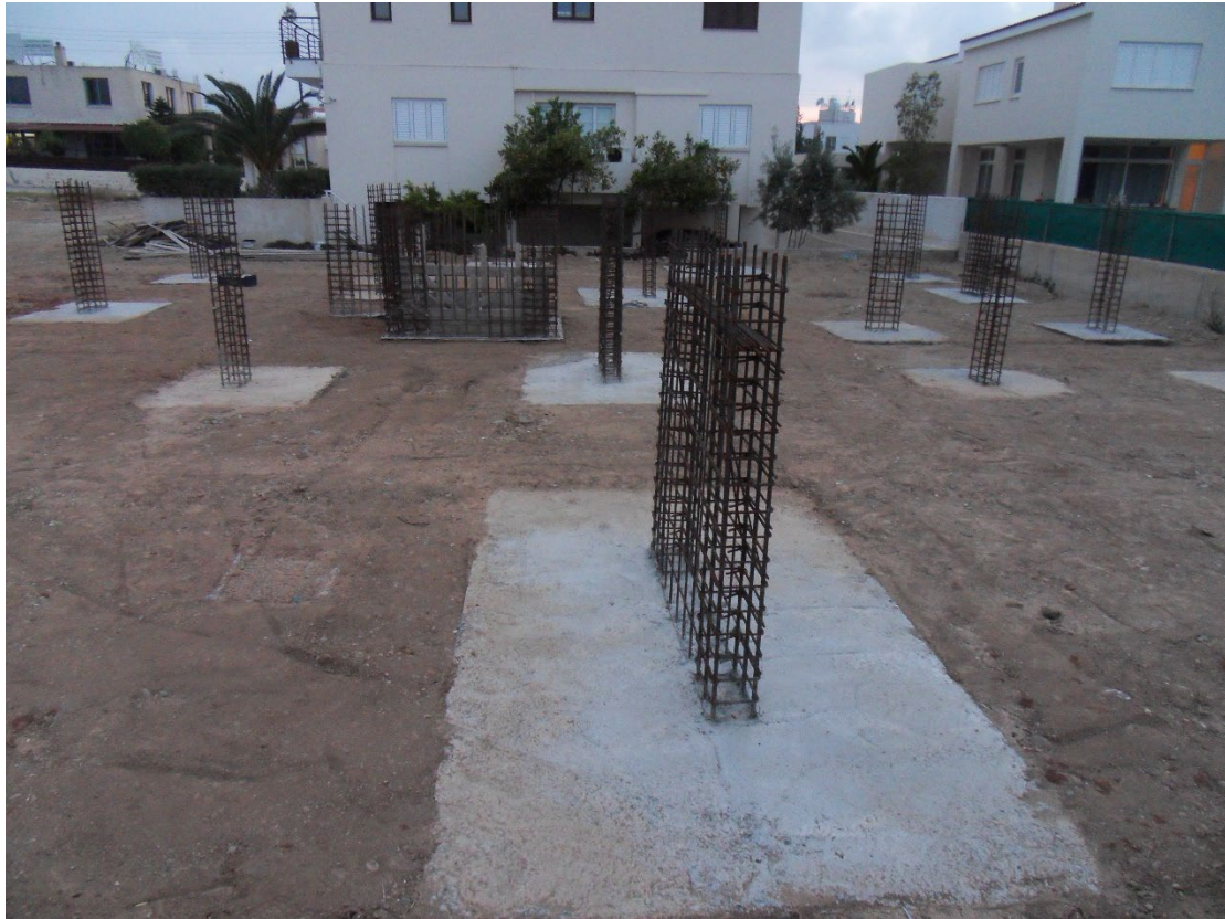
Εικόνα 4.2: Θεμελίωση πολυκατοικίας στη Λευκωσία με μεμονωμένα πέδιλα.
