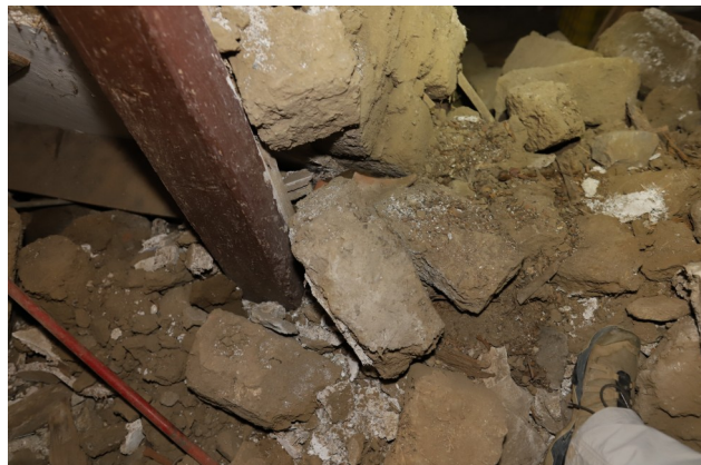
Εικόνα 4_33: Ωμόπλινθοι σε υπό κατάρρευση ιστορικό κτίσμα. Πηγή: T. Κουιμτζόγλου .
