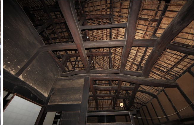
Εικόνα 4_16: Κατασκευή στέγης ιαπωνικής κατοικίας με παραδοσιακό τρόπο όπου στην κατασκευή ενσωματώνονται ξύλινα στοιχεία στη φυσική τους σχεδόν μορφή. Πηγή: Girder / 梁(はり) , https://www.flickr.com/photos/tanaka_juuyoh/8076572660/in/album-72157605568359952/ , εικόνα του/της: TANAKA Juuyoh (田中十洋), άδεια: CC BY 2.0, https://creativecommons.org/licenses/by/2.0/
