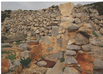
Εικόνα 4_24: Αργολιθοδομή σε αγροικία με αλώνι. Τίτλος: Αγροικία με αλώνι. Πηγή: https://www.searchculture.gr/aggregator/edm/Dig_TEE/000170-18340 , άδεια: CC BY-NC 4.0, https://creativecommons.org/licenses/by-nc/4.0/ . Δεν έχουν γίνει αλλαγές στο αρχείο.
