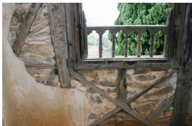
Εικόνα 4_6: Τοιχοποιία από τσατμά με γέμισμα από λίθους και κονίαμα σε κτίσμα στον οικισμό Τρικέρι στη Μαγνησία. Πηγή: Ψηφιακό αποθετήριο μαθήματος Αρχιτεκτονικής ανάλυσης παραδοσιακών κτηρίων και συνόλων (5Α) Σχολής Αρχιτεκτόνων Μηχανικών ΕΜΠ. http://5a.arch.ntua.gr/project/5305/5953 , © Σχολή Αρχιτεκτόνων Μηχανικών ΕΜΠ.
