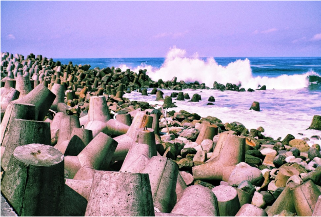
Εικόνα 4_53: Κυματοθραύστες τύπου tetrapods από στοιχεία από οπλισμένο σκυρόδεμα. Πηγή: Wave Breaker On Glagah Beach (246870295).jpeg , Wave Breaker On Glagah Beach , https://commons.wikimedia.org/wiki/File:Wave_Breaker_On_Glagah_Beach_(246870295).jpeg , εικόνα του/της: Nanda Widyatama , άδεια: CC BY 3.0, This file is licensed under the Creative Commons Attribution 3.0 Unported license.
