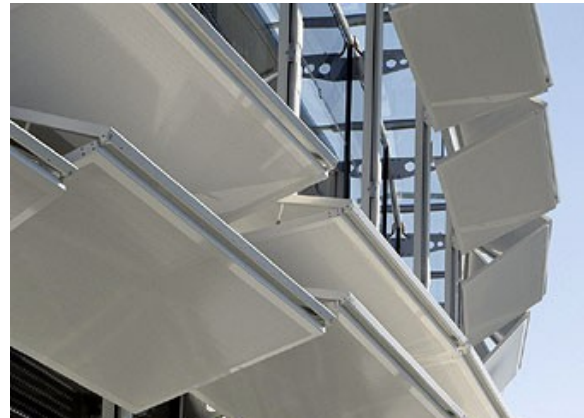
Εικόνα 4_46: Kiefer Technic Showroom, 2007. Λεπτομέρεια κινητών στοιχείων. Πηγή: https://www.giselbrecht.at/projekte/gewerbe_industriebauten/kiefer/index.html , © ERNST GISELBRECHT + PARTNER ZT GMBH, χρήση κατόπιν αδείας.
