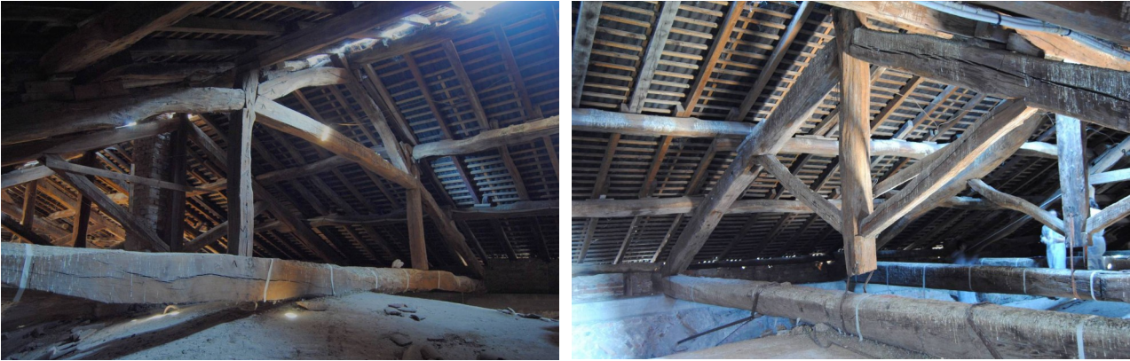
Εικόνα 4_11: Φωτογραφίες εσωτερικού της κατασκευής της ξύλινης στέγης του κυρίως ναού της Βασιλικής του San Michele στην Pavia. Ζευκτό νο.3 (αριστερά), Ζευκτό νο.1 (δεξιά). Πηγή: Emanuele Zamperini, 'The Timber Roof of the Central Nave in the Basilica of San Michele in Pavia' (SAHC2014 – 9th International Conference on Structural Analysis of Historical Constructions, Mexico city, 2014),
