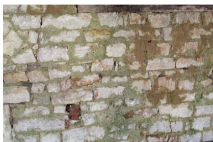
Εικόνα 4_26: Ημιλαξευτή λιθοδομή στο τέμενος Καλούτσιανης στα Ιωάννινα, 2018. Πηγή: Τ. Κουιμτζόγλου
