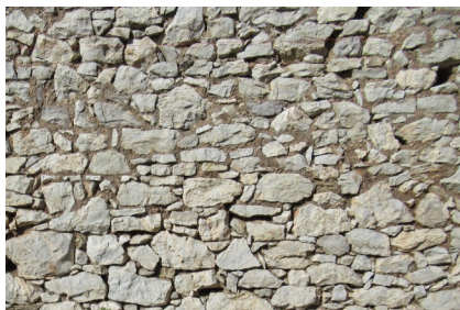
Εικόνα 4_23: Αργολιθοδομή σε παραδοσιακή κατοικία στην Καρύταινα, 2019. Πηγή: Τ. Κουιμτζόγλου
