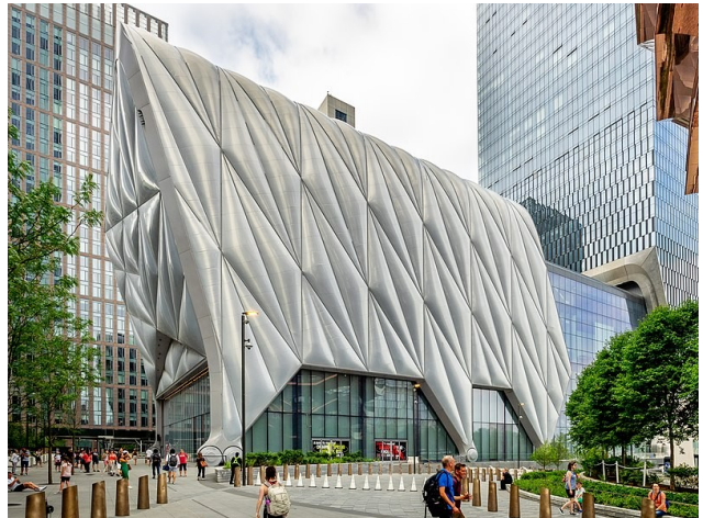
Εικόνα 4_70: The Shed, Diller Scofidio+Renfro, 2019. Το κτήριο/υπόστεγο σε διάταξη συστολής. Πηγή: The Shed - Complete (48206488176).jpg, Hudson Yards, NYC, https://commons.wikimedia.org/wiki/File:The_Shed_-_Complete_(48206488176).jpg , εικόνα του/της: Ajay Suresh from New York, NY, USA, άδεια: CC BY 2.0, Creative Commons Attribution 2.0 Generic license .
