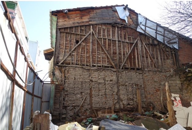
Εικόνα 4_2: Μεσοτοιχία ξύλινου κτίσματος στην Κωνσταντινούπολη. Γενική άποψη (αριστερά) και λεπτομέρεια (δεξιά), όπου διακρίνεται η μια παρειά της τοιχοποιίας και ο ξύλινος φέρων οργανισμός πάνω στον οποίο στηρίζεται το μπαγδατί από πήχεις ξύλου διαφορετικών μεγεθών. Διακρίνεται επίσης το επίχρισμα που έχει συμπληρώσει τα κενά ανάμεσα στις οριζόντιες σανίδες του μπαγδατί. Πηγή: Τ. Κουιμτζόγλου.
