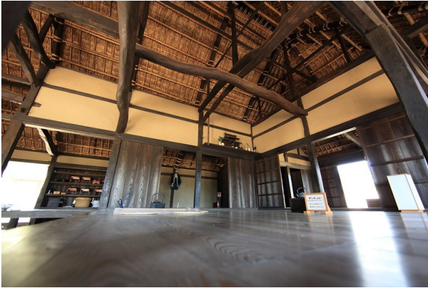
Εικόνα 4_15: Κατασκευή στέγης ιαπωνικής κατοικίας με παραδοσιακό τρόπο όπου στην κατασκευή ενσωματώνονται ξύλινα στοιχεία στη φυσική τους σχεδόν μορφή. Πηγή: Japanese traditional style farm house / 旧土肥 μορφή. Πηγή: Girder / 梁(はり) , 家住宅(きゅうどいけじゅうたく) https://www.flickr.com/photos/tanaka_juuyoh/6142380486/in/album-72157605568359952/ , εικόνα του/της: TANAKA Juuyoh (田中十洋), άδεια: CC BY 2.0, https://creativecommons.org/licenses/by/2.0/
