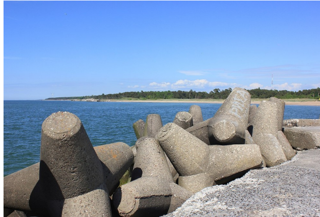
Εικόνα 4_54: Κυματοθραύστες tetrapods από στοιχεία από οπλισμένο σκυρόδεμα. Πηγή: Liepaja Karosta falochron polnocny 2.jpg , Liepaja - Karosta - northern breakwater , https://commons.wikimedia.org/wiki/File:Liepaja_Karosta_falochron_polnocny_2.jpg , εικόνα του/της: Andrzej Otrębski , άδεια: CC BY-SA 4.0, Creative Commons Attribution-Share Alike 4.0 International license. Δεν έχουν γίνει αλλαγές στο αρχείο.
