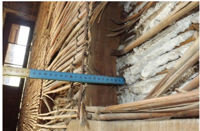
Εικόνα 4_4: Μπαγδατί από κλαδιά ως κατακόρυφη και οριζόντια αλαφριά κατασκευή σε κτίσμα στον οικισμό Αργαλαστής στη Μαγνησία. Πηγή: Ψηφιακό αποθετήριο μαθήματος Αρχιτεκτονικής ανάλυσης παραδοσιακών κτηρίων και συνόλων (5Α) Σχολής Αρχιτεκτόνων Μηχανικών ΕΜΠ. http://5a.arch.ntua.gr/project/5301/5709 , © Σχολή Αρχιτεκτόνων Μηχανικών ΕΜΠ.
