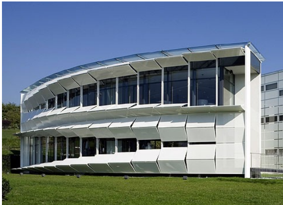
Εικόνα 4_45: Kiefer Technic Showroom, 2007. Γενική διάταξη όψης. Πηγή: https://www.giselbrecht.at/projekte/gewerbe_industriebauten/kiefer/index.html , © ERNST GISELBRECHT + PARTNER ZT GMBH, χρήση κατόπιν αδείας.
