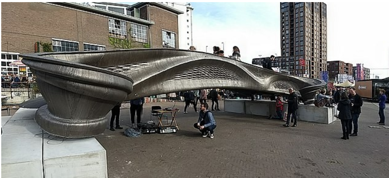
Εικόνα 4_92: Γέφυρα MX3D, 2021 σε δοκιμαστική τοποθέτηση. Πηγή: MX3D 3D printed bridge Dutch Design Week.jpg, Een 3D-geprinte brug van MX3D tijdens de Dutch Design Week op 20 oktober 2018 te Eindhoven, https://commons.wikimedia.org/wiki/File:MX3D_3D_printed_bridge_Dutch_Design_Week.jpg , εικόνα του/της: IIVQ / Tijmen Stam, άδεια: CC BY-SA 4.0, Creative Commons Attribution-Share Alike 4.0 International license. Δεν έχουν γίνει αλλαγές στο αρχείο.
