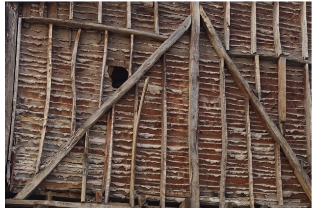
Εικόνα 4_2: Μεσοτοιχία ξύλινου κτίσματος στην Κωνσταντινούπολη. Γενική άποψη (αριστερά) και λεπτομέρεια (δεξιά), όπου διακρίνεται η μια παρειά της τοιχοποιίας και ο ξύλινος φέρων οργανισμός πάνω στον οποίο στηρίζεται το μπαγδατί από πήχεις ξύλου διαφορετικών μεγεθών. Διακρίνεται επίσης το επίχρισμα που έχει συμπληρώσει τα κενά ανάμεσα στις οριζόντιες σανίδες του μπαγδατί. Πηγή: Τ. Κουιμτζόγλου.
