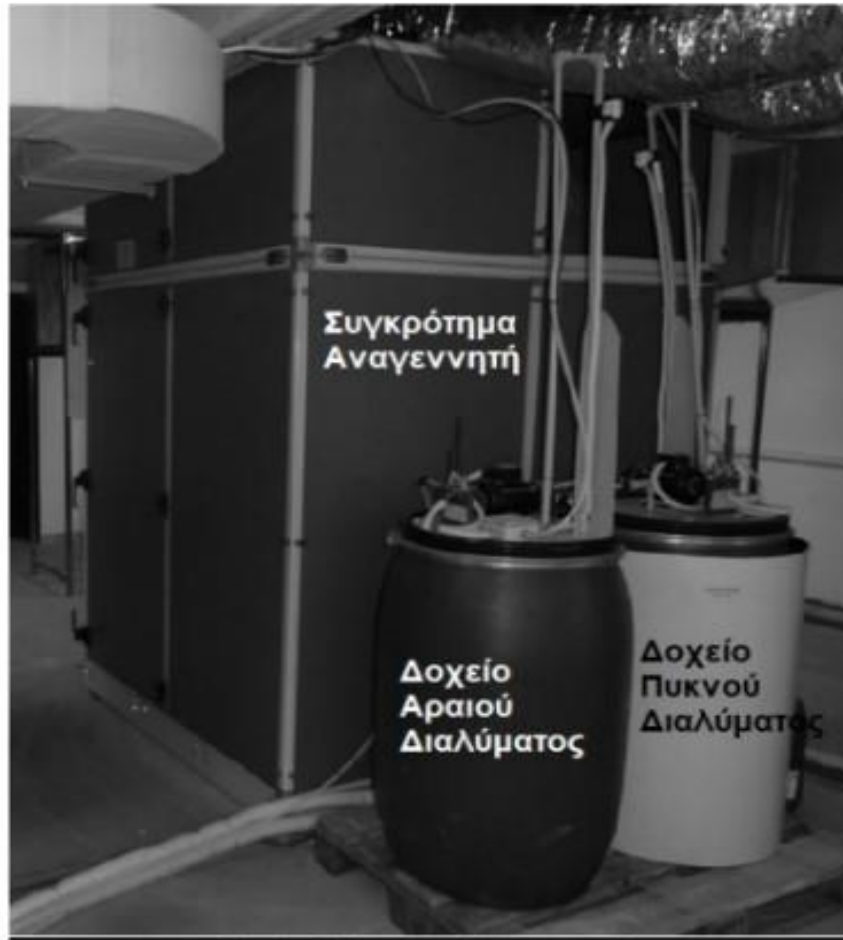
Εικόνα 10. Δοχεία Διαλύματος και εξωτερικό αναγεννητή
