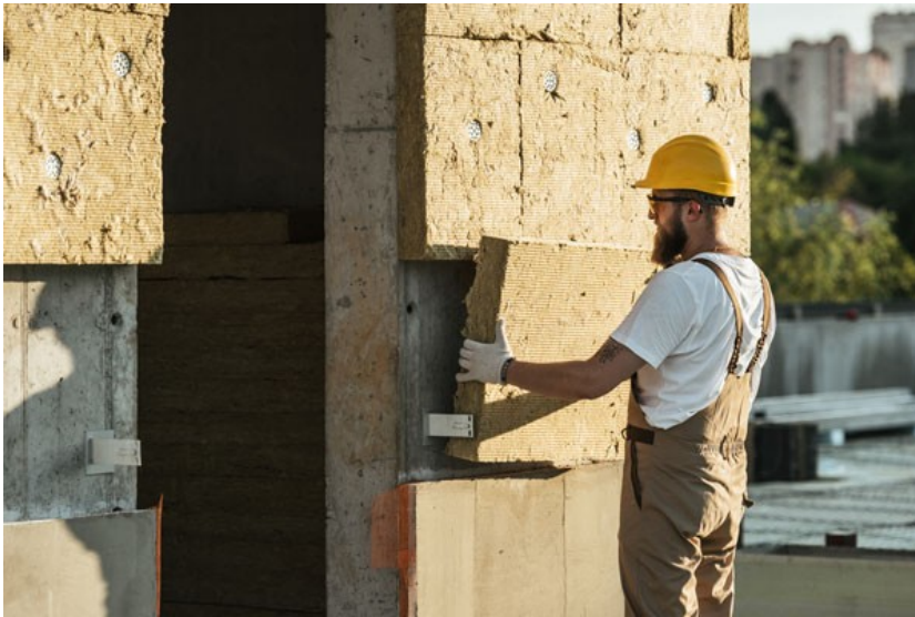
Εικόνα 8.9: Συνήθης τρόπος τοποθέτησης εξωτερικής μόνωσης
