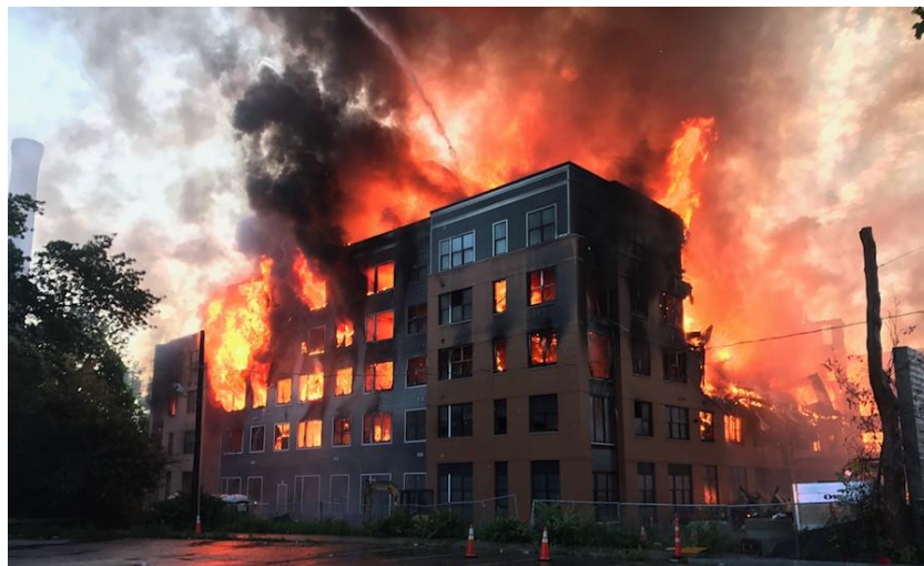
Εικόνα 1.2 Φωτιά σε πολυκατοικία, Waltham Fire Dept. (2017)
