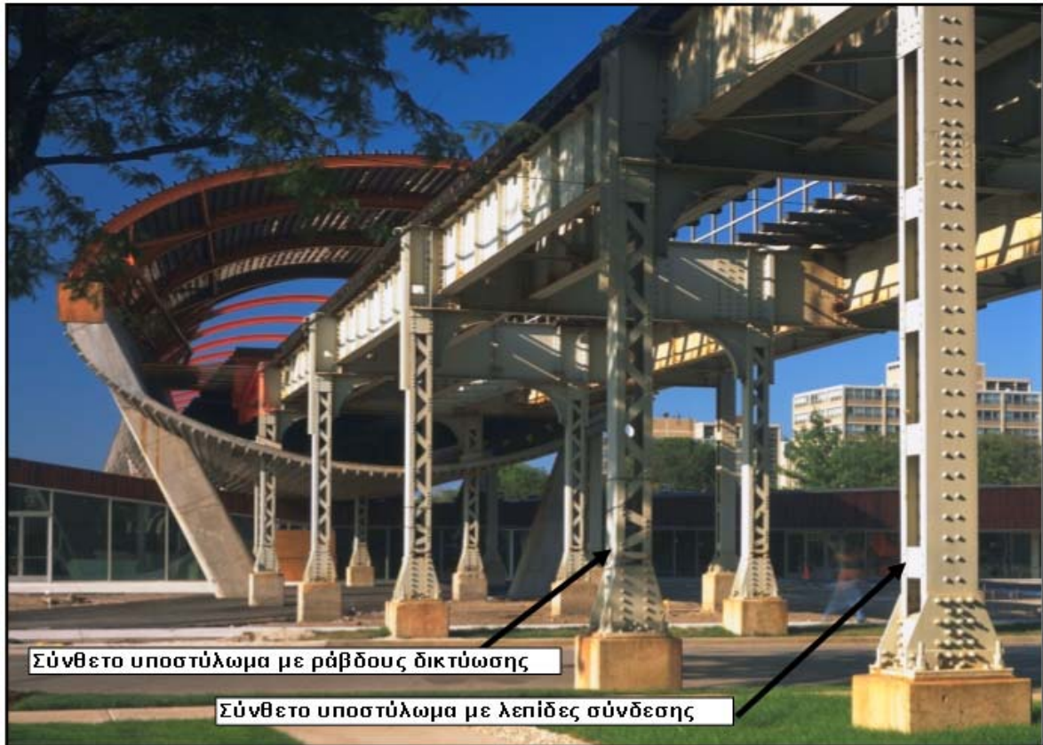
Σχήμα 1.2: Σιδηροδρομική γέφυρα που εδράζεται σε σύνθετα υποστυλώματα.
