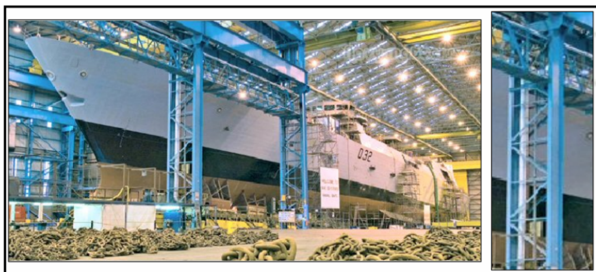
Σχήμα 1.4: Ναυπηγική εγκατάσταση με σύνθετα υποστυλώματα μεγάλου μήκους η σύνδεση των οποίων γίνεται με ράβδους δικτύωσης.
