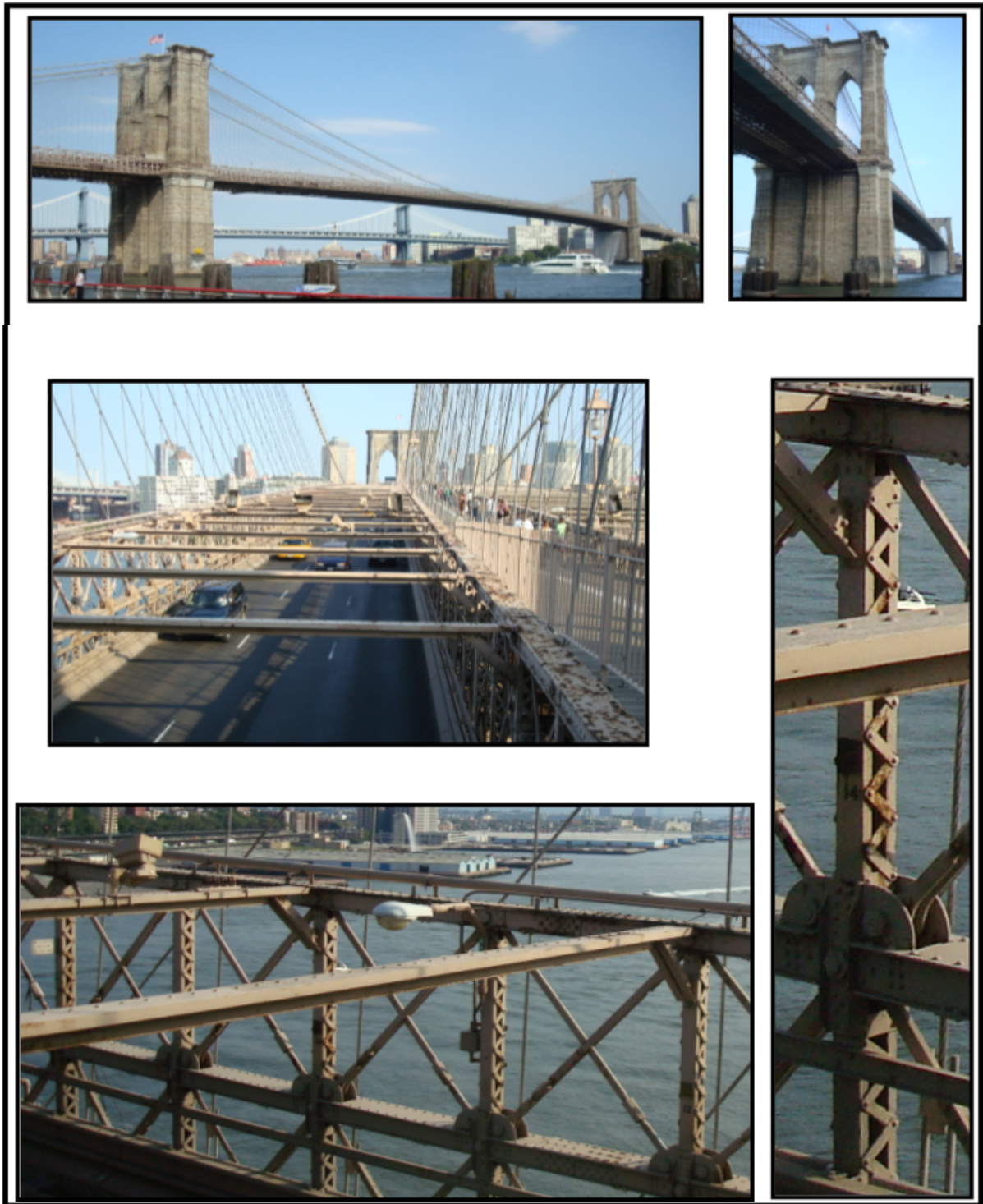
Σχήμα 1.5: Brooklyn Bridge στη Νέα Υόρκη – σύνθετα υποστυλώματα με ράβδους δικτύωσης
