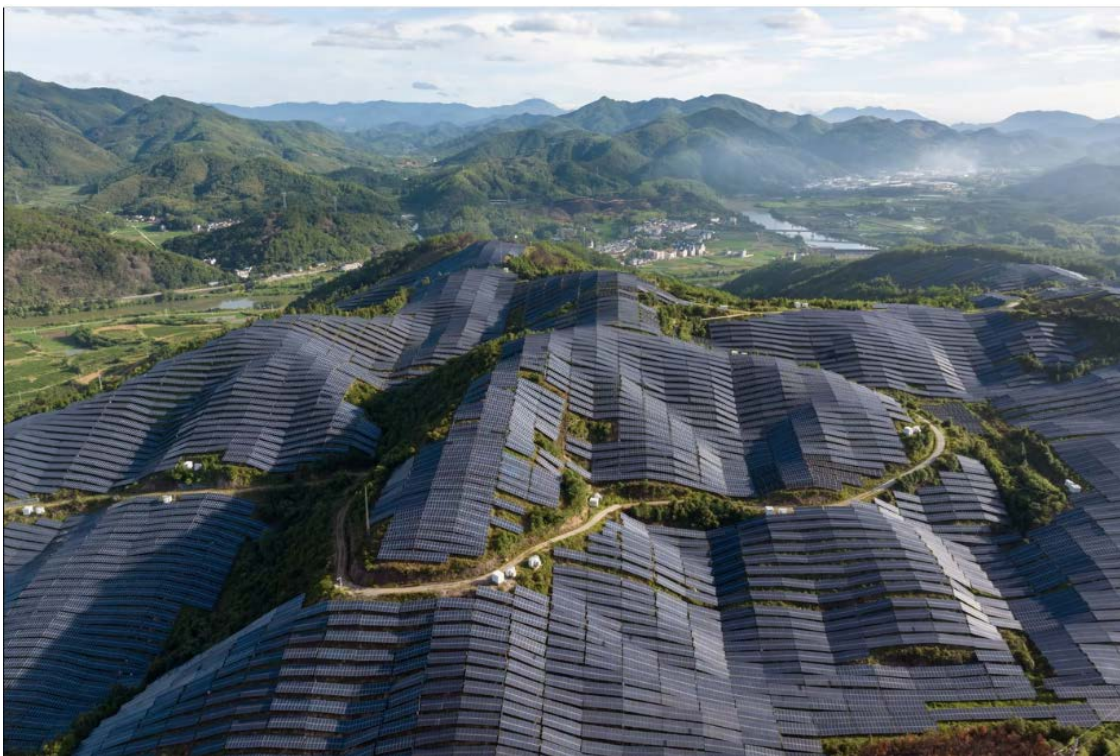
Εικόνα 1-2: Πάρκο φωτοβολταϊκών στην επαρχία Φουτσιάν, Κίνα (Taylor, 2023)
