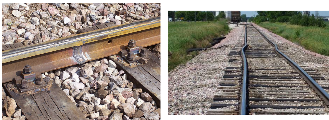
Εικόνα 4.9 Σημείο συγκόλλησης σιδηροτροχιών και περίπτωση στρέβλωσης ραγών. (Πηγή Διαδίκτυο)
