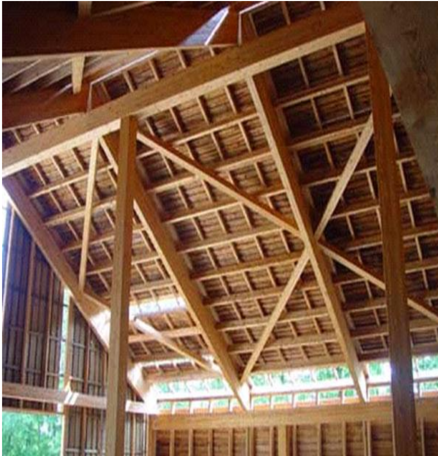
( http://www.platowood.nl/ ) Εικ.6. Ξύλινη κατασκευή στέγης
