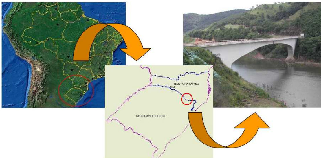
Εικόνα 2.21 Η γέφυρα Rio Pelotas
