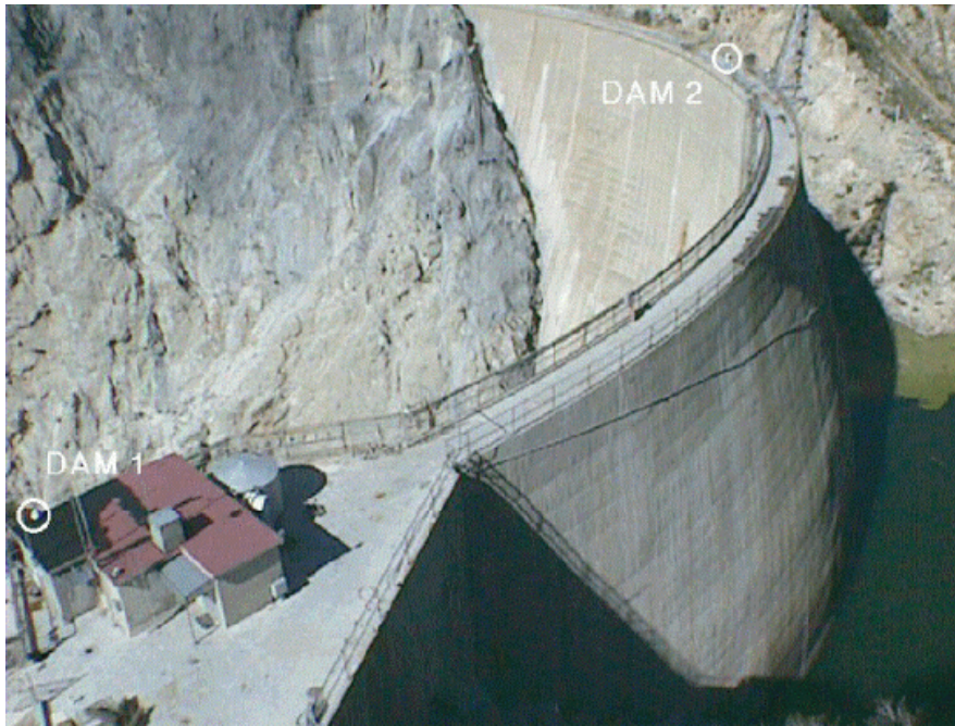
Εικόνα 2.12 Οι θέσεις των δύο δεκτών GPS στην κορυφή του φράγματος
