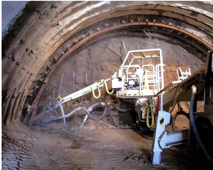
Εικόνα 3.3: Ομπρέλα δοκών προπορείας.
