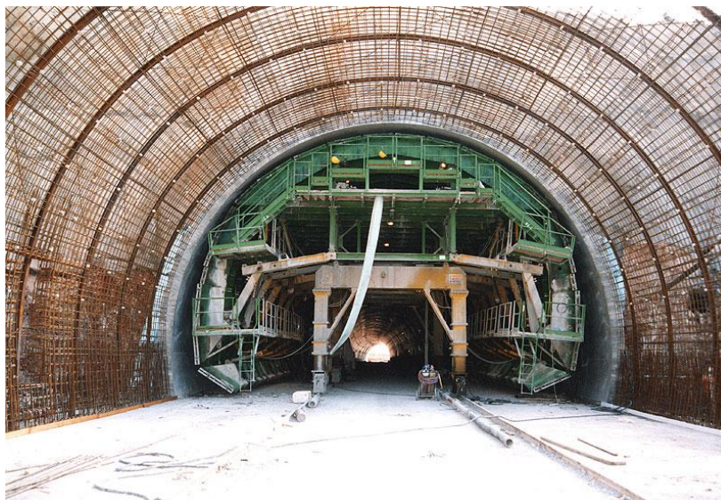
Εικόνα 1.1: Καλούπι σκυροδέτησης της τελικής επένδυσης (χελώνα).
