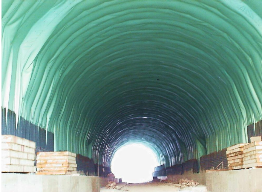
Εικόνα 4.1: Στεγανωτική μεμβράνη τελικής επένδυσης.
