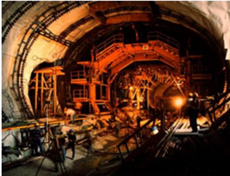
Εικόνα 3.1: Διάνοιξη σήραγγας με τη μέθοδο NATM.
