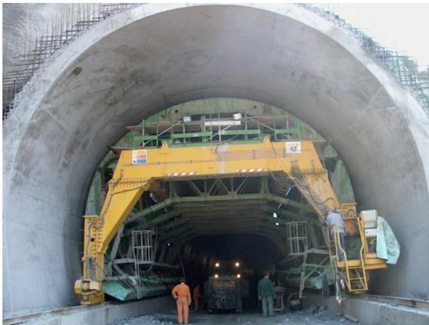
Εικόνα 4.2: Μεταλλότυπος για τη σκυροδέτηση της τελικής επένδυσης (χελώνα).
