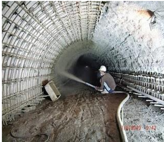
Εικόνα 3.2: Μέτρα προσωρινής υποστήριξης σήραγγας.
