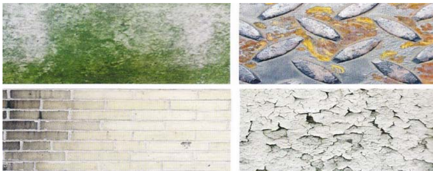
Σχήμα 41: Επίδραση υγρασίας σε επίχρισμα, μέταλλο, τούβλα, βαφές
