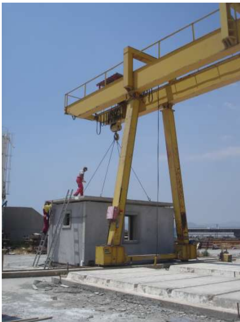
Εικόνα 9. Τοποθέτηση προκατασκευασμένης πλάκας οροφής
