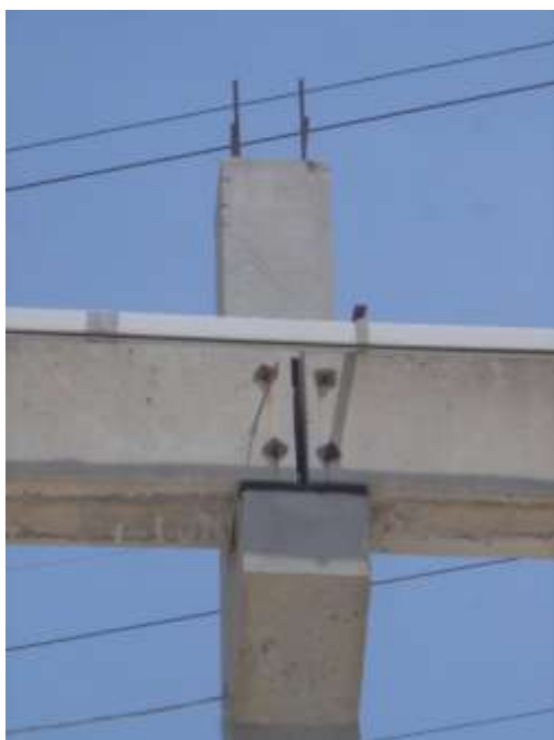
Εικόνα 8. Σύνδεση δοκών-υποστυλώματος μέσω κοντού προβόλου
