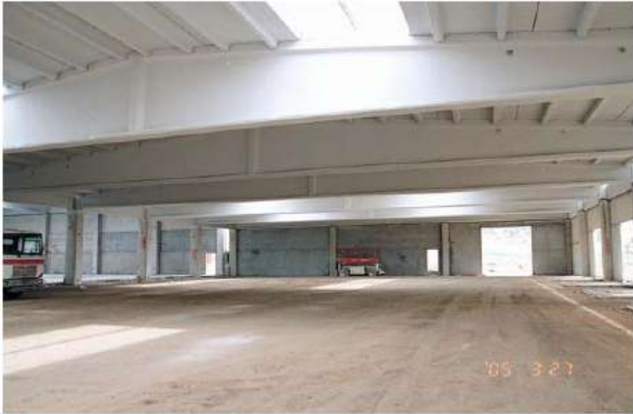
Εικόνα 3. Τυπικό φάτνωμα ανοίγματος 30.00m, συντιθέμενο από προκ/να γραμμικά φέροντα στοιχεία
