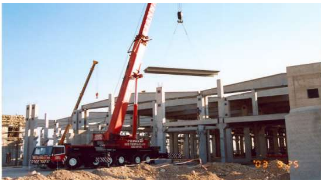
Εικόνα 17. Τοποθέτηση πλάκας οροφής επί των ζευκτών
