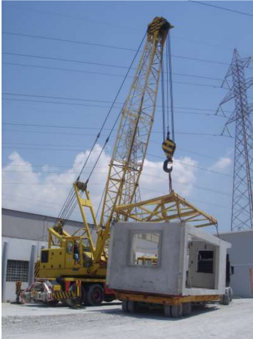
Εικόνα 12. Ανάρτηση κυψέλης από γερανό μέσω μεταλλικού πλαισίου
