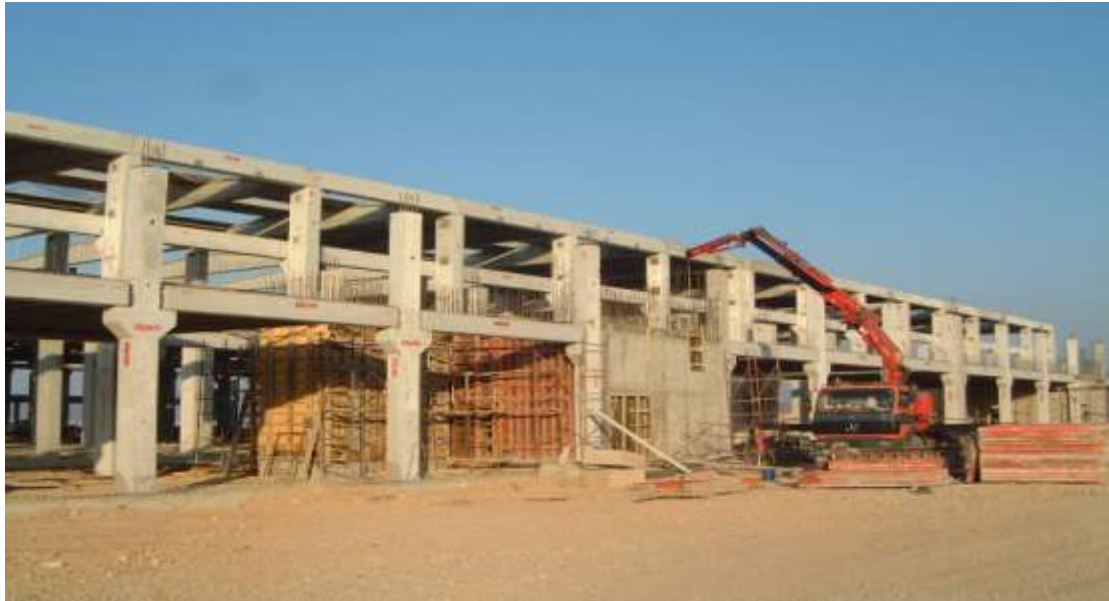
Εικόνα 16. Προκατασκευασμένος σκελετός διόροφου βιομηχανικού κτιρίου-Σκυροδέτηση χυτού τοιχωμάτος ακαμψίας
