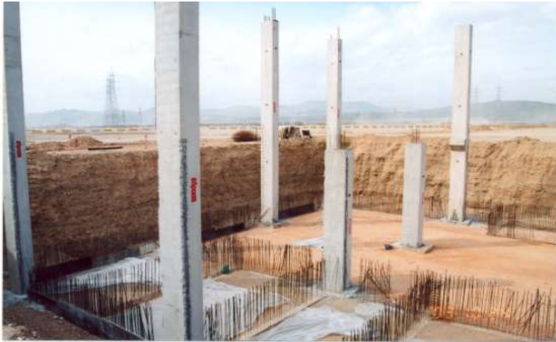
Εικόνα 7. Προκατασκευασμένα υποστυλώματα πακτωμένα στους κώνους
