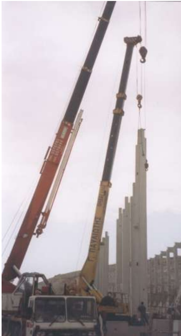
Εικόνα 13. Κατακορύφωση-τοποθέτηση υποστυλώματος στην θήκη θεμελίωσης (κώνο)
