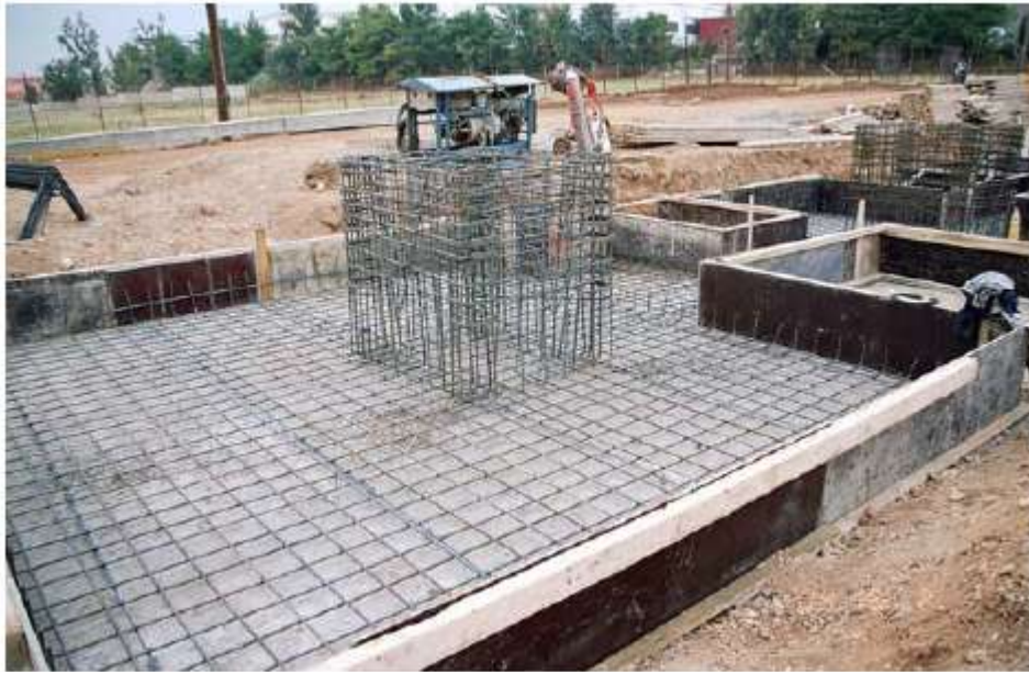
Εικόνα 4. Θεμελίωση (επιτόπου εγχυνόμενο πέδιλο και θήκη θεμελιώσεως)
