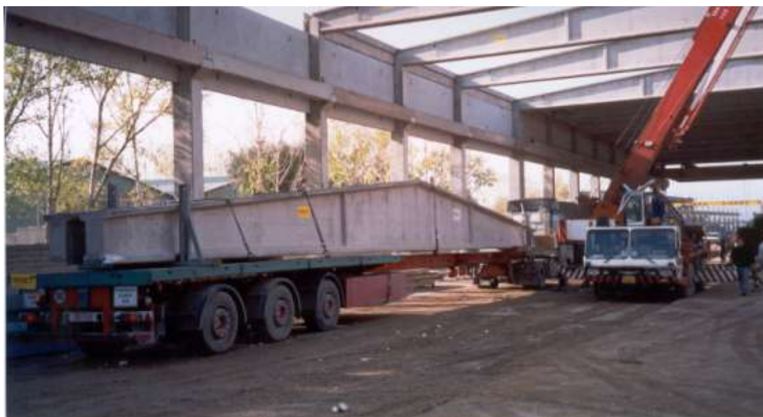
Εικόνα 21. Ζεύγος ζευκτών επί του ειδικού οχήματος μεταφοράς
