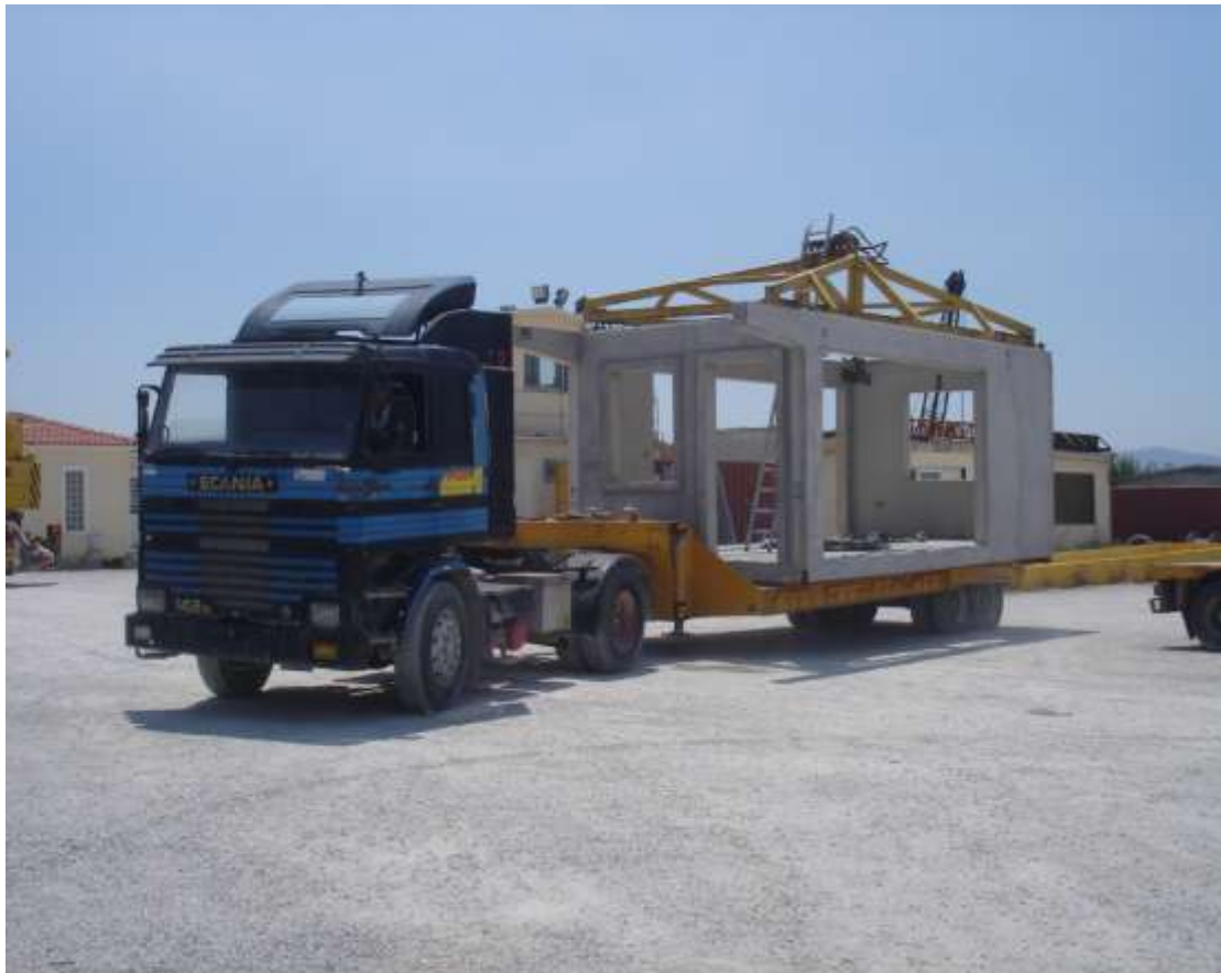
Εικόνα 11. Μεταφορά κυψέλης εντός του εργοστασίου
