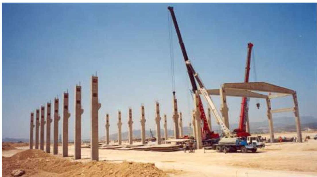
Εικόνα 15. Τοποθέτηση ζευκτών
