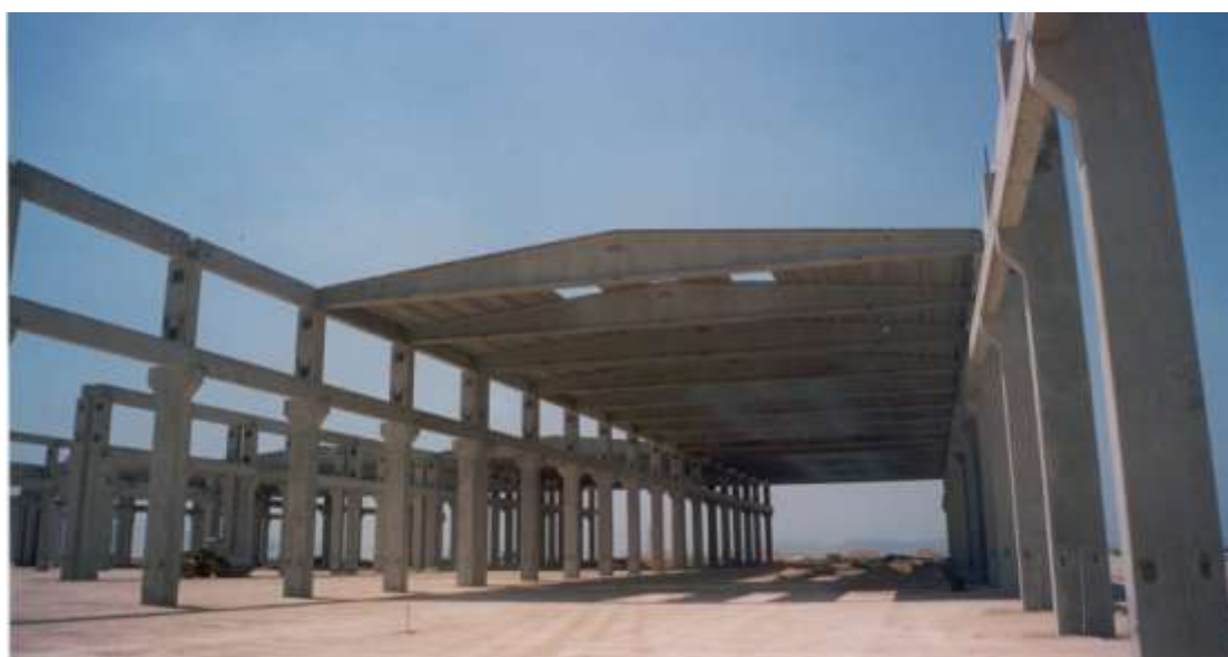
Εικόνα 18. Ενδιάμεσο στάδιο επαναλαμβανόμενης συναρμολόγησης παράλληλων φατνωμάτων.
