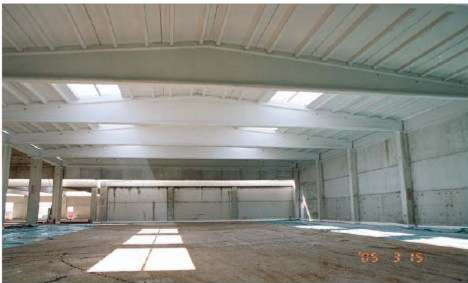
Εικόνα 2. Τυπικό φάτνωμα ανοίγματος 28.00m, συντιθέμενο από προκ/να γραμμικά φέροντα στοιχεία
