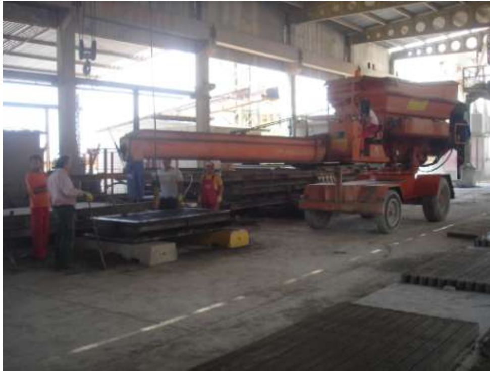
Εικόνα 20. Διάστρωση σκυροδέματος με αυτοκινούμενο όχημα με κοκλία προώθησης του σκυροδέματος τύπου Speedy
