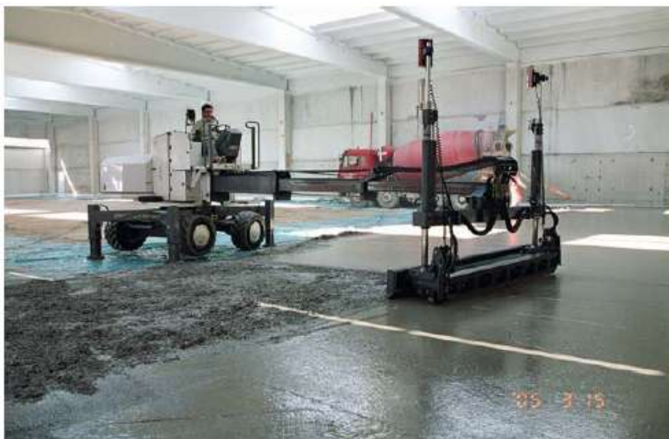
Εικόνα 6. Σκυροδέτηση δαπέδων
