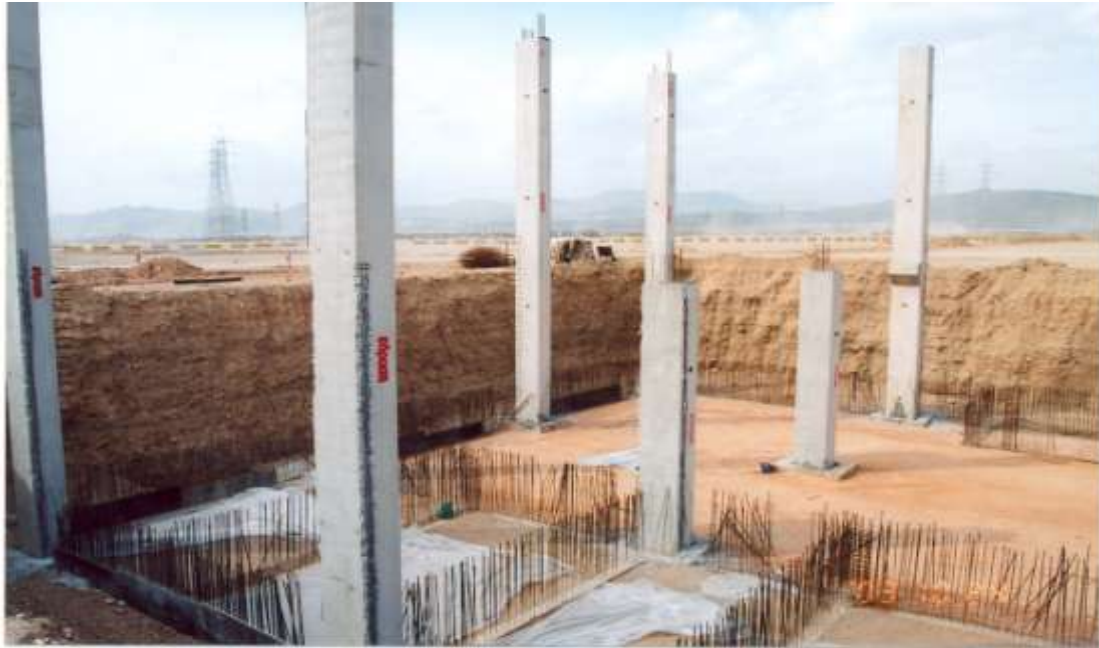
Εικόνα 14. Υποστυλώματα εντός των κώνων θεμελίωσης-κατασκευή περιμετρικών τοιχείων
