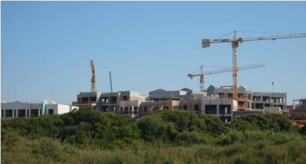
Εικόνα: Κατασκευή υποδομών ΠΟΤΑ Ρωμανού. [επιτόπια έρευνα]
