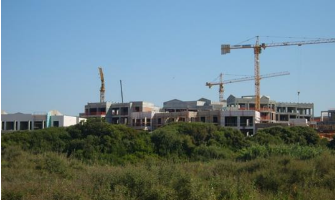
Εικόνα: Εργασίες κατασκευής της ΠΟΤΑ Ρωμανού. [επιτόπια έρευνα]
