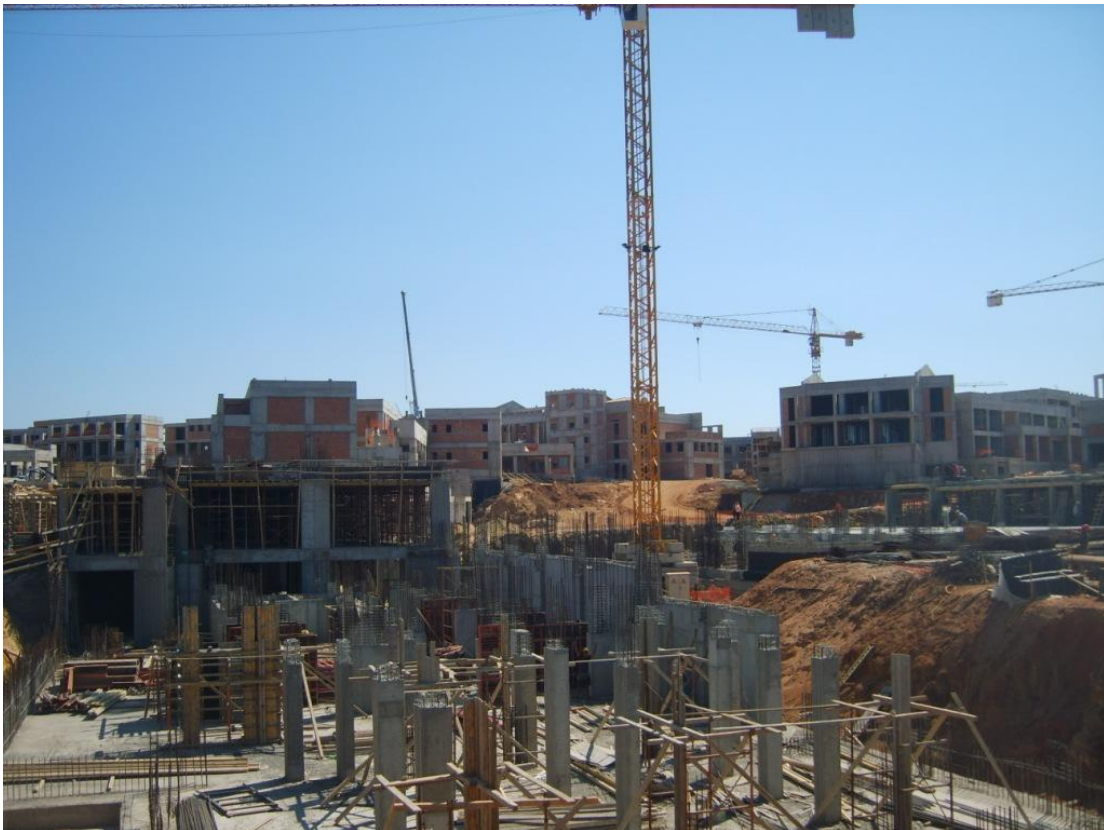
Εικόνα: Κατασκευή κτιρίων της ΠΟΤΑ Ρωμανού. [επιτόπια έρευνα]
