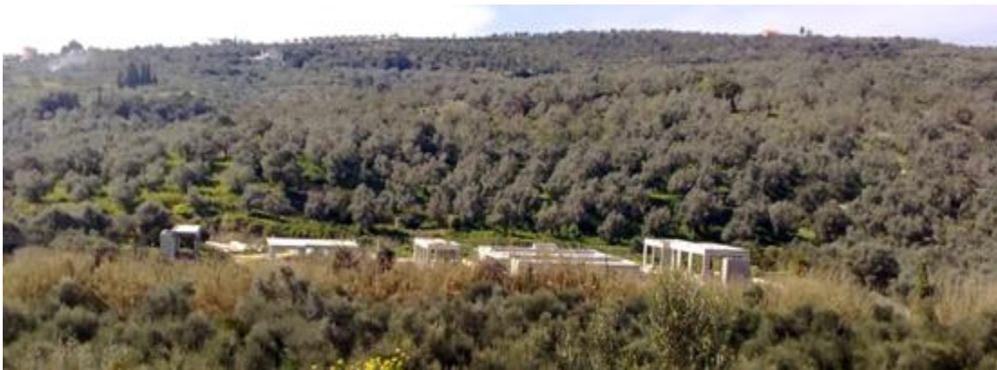
Εικόνα: Εργασίες κατασκευής μονάδας βιολογικού καθαρισμού που θα συνδεθεί η ΠΟΤΑ Ρωμανού. [επιτόπια έρευνα]
