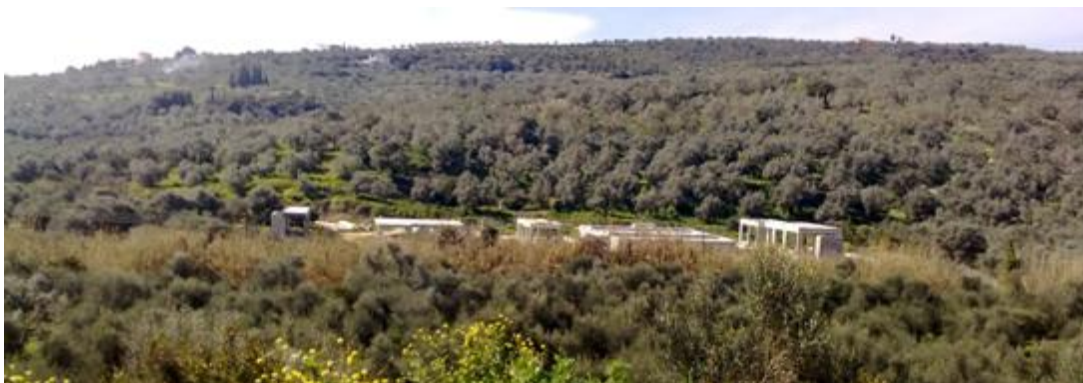
Εικόνα: Οι, υπό κατασκευή, εγκαταστάσεις της μονάδας βιολογικού καθαρισμού. [επιτόπια έρευνα]
