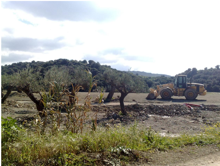
Εικόνα: Εργασίες κατασκευής της ΠΟΤΑ Πύλου και μεταφυτεμένα ελαιόδενδρα. [επιτόπια έρευνα]
