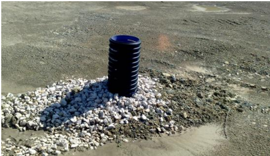
Εικόνα: Εργασίες κατασκευής δικτύου αποχέτευσης στο τμήμα της ΠΟΤΑ Πύλου. [επιτόπια έρευνα]
