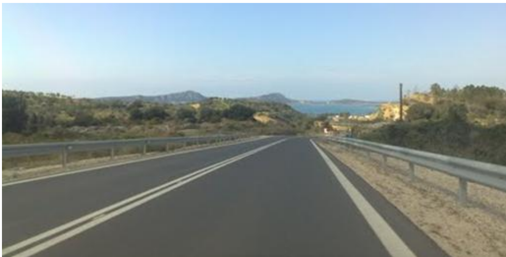
Εικόνα: Το νέο τμήμα της Εθνικής Οδού Γαργαλιάνων-Πύλου, που παρακάμπτει την ΠΟΤΑ. Ο χώρος που κατασκευάστηκε ο δρόμος ήταν ιδιοκτησίας ΤΕΜΕΣ. Στο βάθος ο όρμος του Ναβαρίνου και η Σφακτηρία. [επιτόπια έρευνα]
