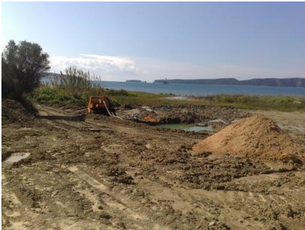
Εικόνα: Έργα πλησίον της παραλίας της ΠΟΤΑ. Στο βάθος η Σφακτηρία. [επιτόπια έρευνα]
