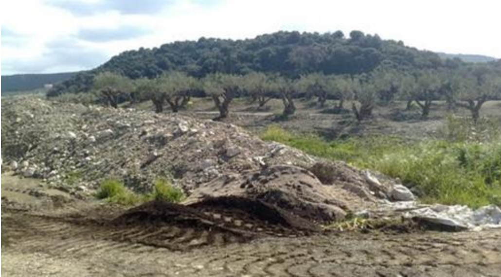
Εικόνα: Άποψη των έργων διαμόρφωσης του εδάφους και μεταφυτεμένα ελαιόδεντρα. [επιτόπια έρευνα]
