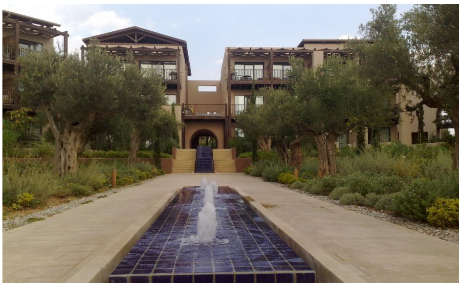
Εικόνα: Εσωτερικοί χώροι ΠΟΤΑ Ρωμανού. [επιτόπια έρευνα]
