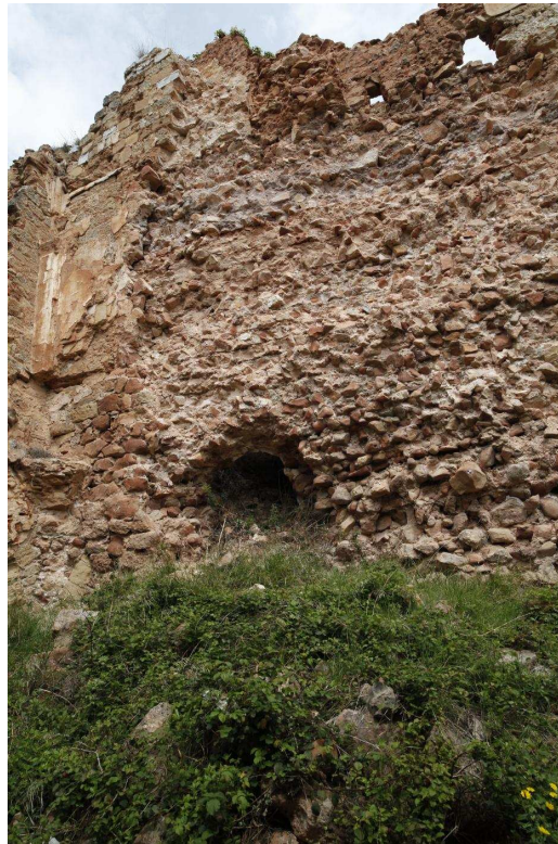
Εικόνα_28: Δυτικό τμήμα του Βορείου τοίχου με μη κανονική επιφάνεια
