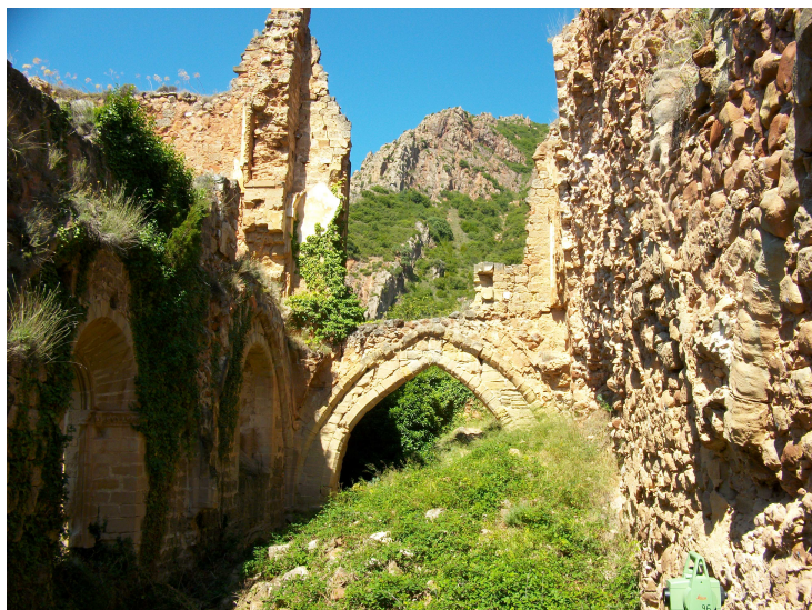
Εικόνα_6: Εσωτερικό της εκκλησίας του Μοναστηριού του Σαν Προυντένθιο
