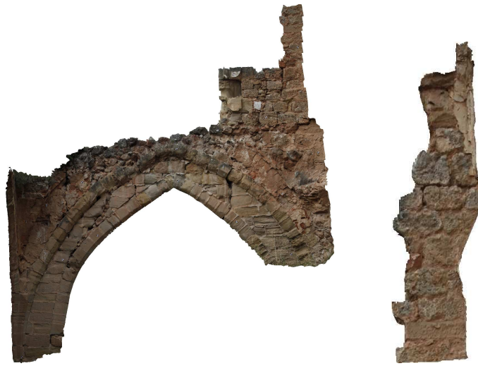
Εικόνες_54 & 55: Ορθοφωτογραφίες του δυτικού τοίχου
