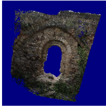
Εικόνες_39, 40 & 41: Νέφη σημείων του νοτίου τοίχου
