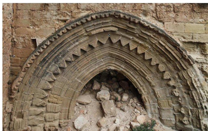
Εικόνα_7: Τμήμα της εισόδου της εκκλησίας, νότιος τοίχος
