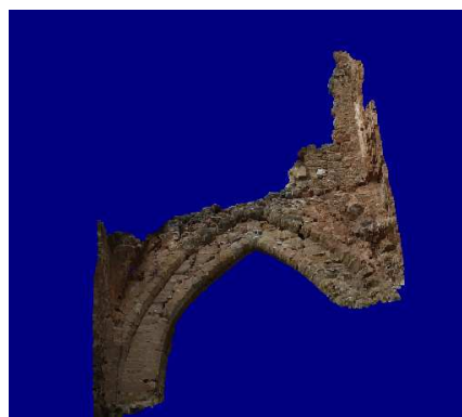
Εικόνα_43: Νέφος σημείων του δυτικού τοίχου
