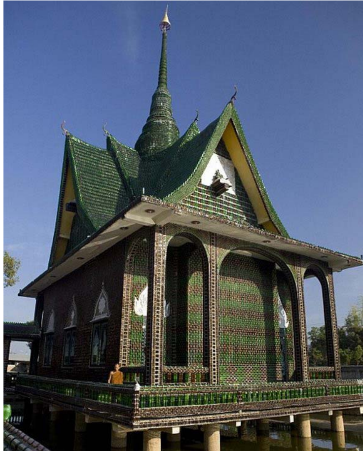
Εικόνα 2.9 Ο ναός Wat Pa Maha Chedi Kaew, που βρίσκεται στο Sisaket της Ταϊλάνδης και είναι κατασκευασμένος από ένα εκατομμύριο φιάλες μύρας
