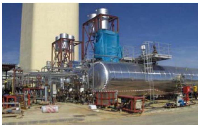
Σχήμα 2.12 Σύστημα Αποθήκευσης Ατμού του Σταθμού PS10. [41]
