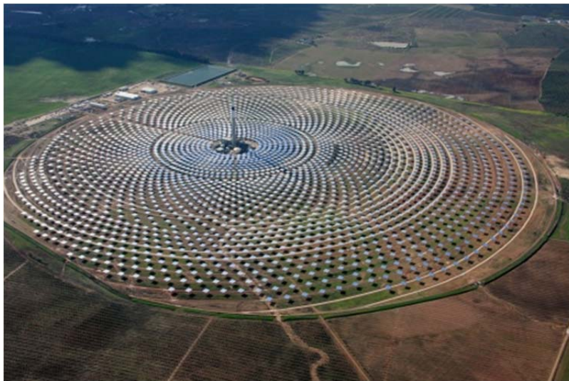
Σχήμα 4.2 Περιβάλλουσα Διάταξη Ηλιοστατικού Πεδίου του Πύργου Gemasolar. [64]
