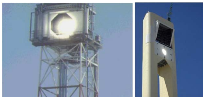
Σχήμα 2.5 Παράδειγμα Ηλιακού Δέκτη Κοιλότητας. [39],[40]
