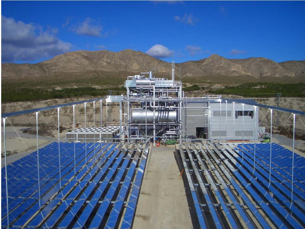
Σχήμα 1.19 Τοπικό Σύστημα με Γραμμικούς Ανακλαστήρες τύπου Fresnel. [27]
