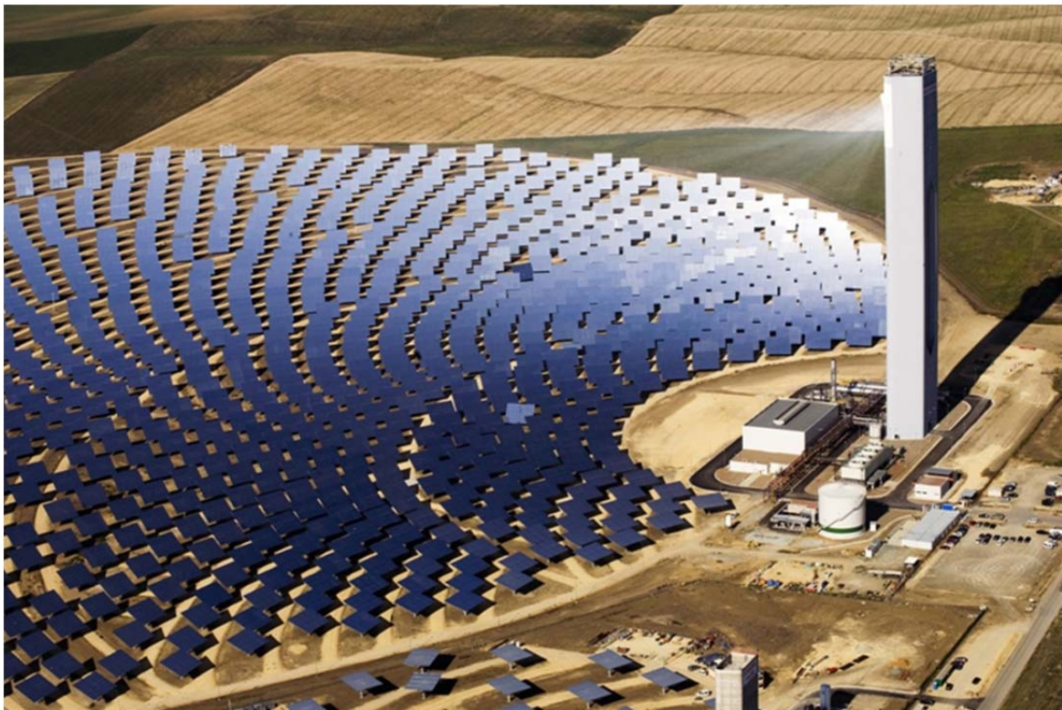
Σχήμα 1.17 Τοπικό Σύστημα Πύργου Ηλιακής Ισχύος. [25]
