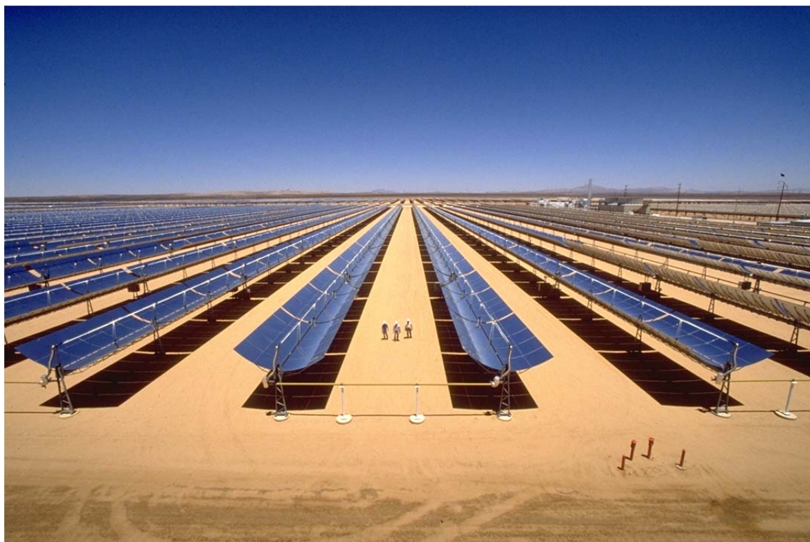
Σχήμα 1.16 Τυπικό Σύστημα Παραβολικών Κοίλων Συλλεκτών. [24]
