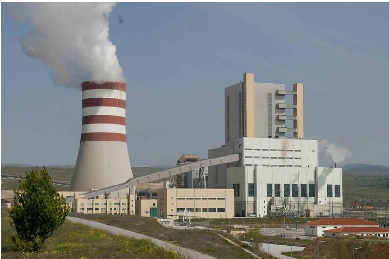
Εικόνα 3.1: Ατμοηλεκτρικός σταθμός Μελίτης Φλώρινας
