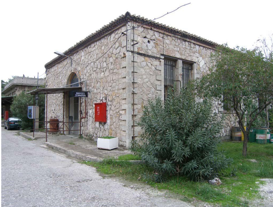
Εικόνα 6.6: Το Γομωτήριο, κτίριο που προτείνεται να διατηρηθεί (βλέπε Παράρτημα, εικόνα 3, κτίριο Β)
