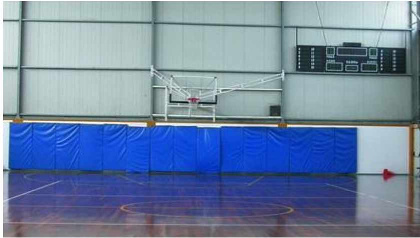
Εικόνα 3.15: Άποψη του εσωτερικού του Κλειστού Γυμναστηρίου της οδού Ελευθερωτών μετά την αποπεράτωσή του από τον Δήμο. (Πηγή: www.argianas.gr )
