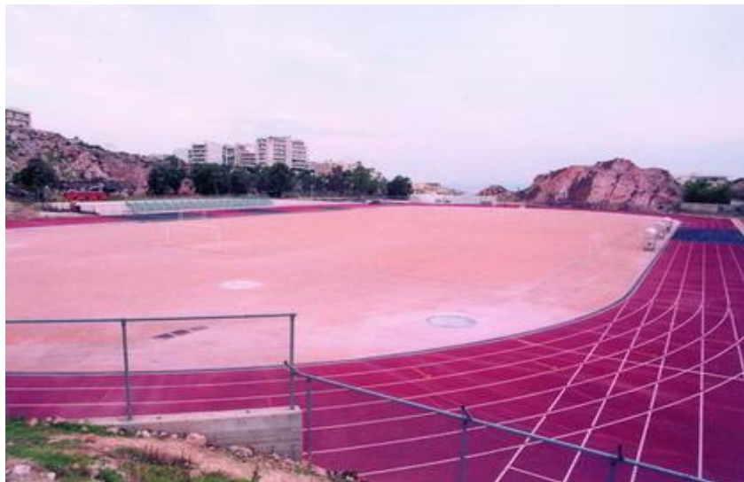
Εικόνα 3.16: Το Δημοτικό Στάδιο λίγο πριν την ολοκλήρωσή του. (Πηγή: www.argianas.gr )
