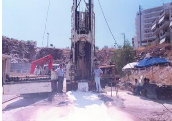
Εικόνα 3.13: Έργα γεωτρήσεων στα Νταμάρια για την πυρασφάλεια πάρκων και το πότισμα κοινοχρήστων χώρων. (Πηγή: www.argianas.gr )
