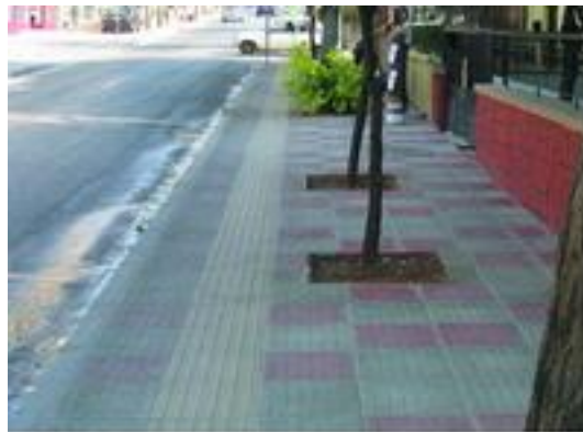
Εικόνα 3.6: Διαπλάτυνση πεζοδρομίων μεγαλύτερη των 2.00μ. (Πηγή: www.argianas.gr )
