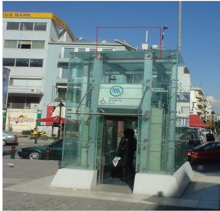
Εικόνα 4.4:Κεραία κινητής τηλεφωνίας στον ανελκυστήρα του μετρό Δάφνης. ( Πηγή:dsi.gr)
