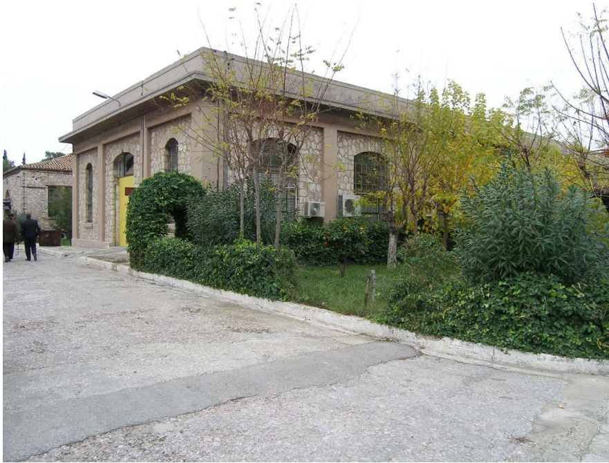
Εικόνα 6.5: Πέτρινο κτίριο που προτείνεται να διατηρηθεί (βλέπε Παράρτημα, εικόνα 3, κτίριο Α)
