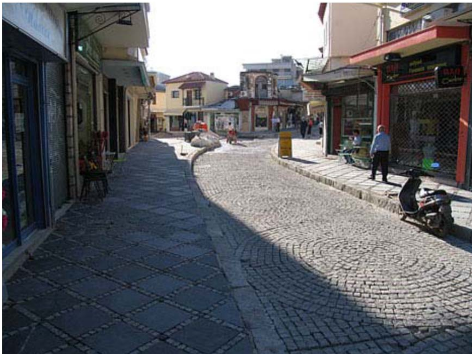
Διαμόρφωση οδού Ανεξαρτησίας
