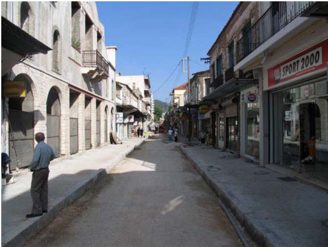
Διαμόρφωση οδού Ανεξαρτησίας
