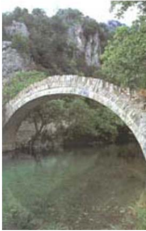
Πέτρινη γέφυρα στο Βοϊδομάτη
