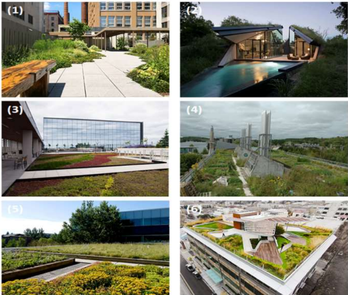
Εικόνα 1 Πράσινες στέγες σε κτίρια κατοικιών (1,2), θεσμικά κτίρια (3,4), εμπορικά κτίρια (5,6) (Shafique, et al., 2018)
