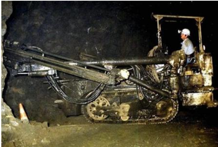
Εικόνα 11.8. Κοχλίωση παρειών στοάς για την αποφυγή ατυχήματος
