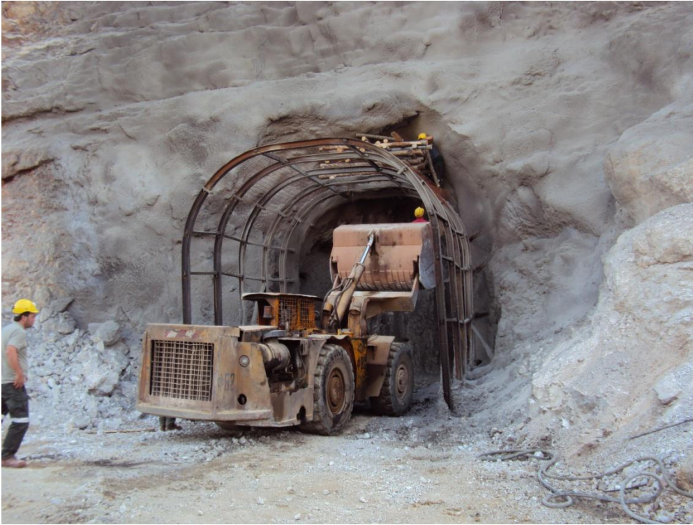
Εικόνα 11.7. Ενίσχυση εισόδου στοάς με κατασκευή από χάλυβα και σκυρόδεμα
