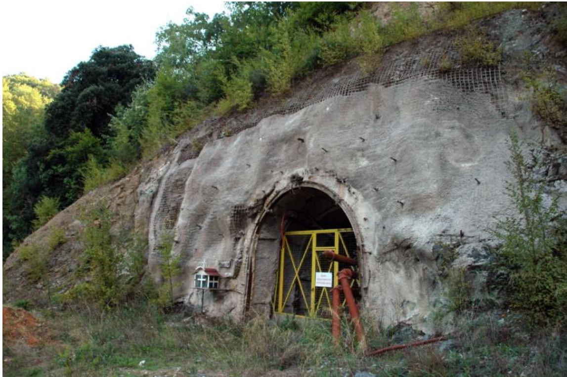
Εικόνα 11.6 Εξωτερικά μέτρα προστασίας.
