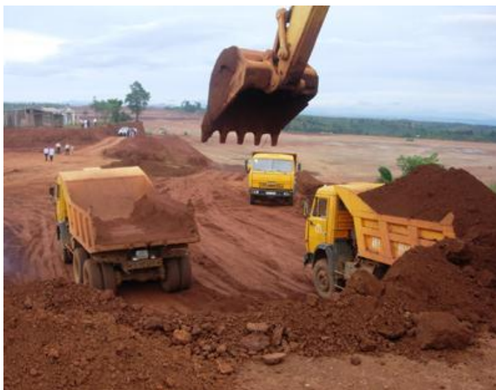
Εικόνα 13.1 Καθάρισμα εργοταξίου έπειτα από κατολίσθηση
