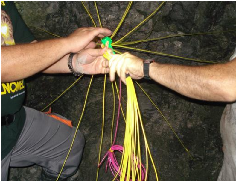
Εικόνα 7.9 Συνδεσμολογία καψυλλίων
