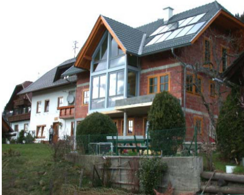
Εικόνα 7.10: Σύστημα combi στην Αυστρία
