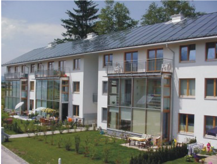
Εικόνα 3: Ηλιακή στέγη σε Αυστριακό σύστημα combi [17]
