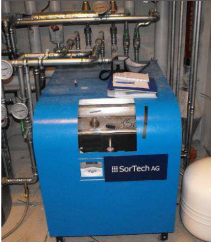
Εικόνα 8.10: Ψύκτης προσρόφησης 7.5 kW
