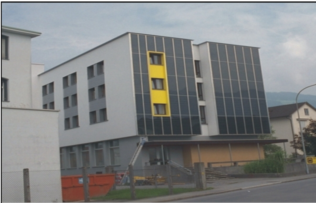
Εικόνα 9: Συλλέκτες τοποθετημένοι στη (νότια) όψη κτιρίου στην Αυστρία[17]
