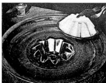
Σχήμα 3.1: Κλασική τεχνολογία σφυρηλάτησης οδοντωτού τροχού
