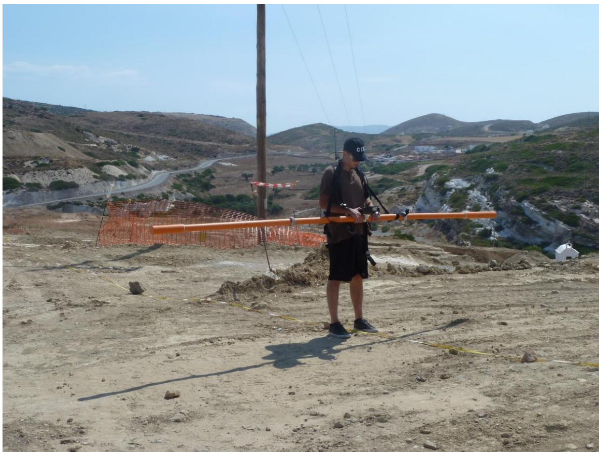
Σχήμα 4.12. Ηλεκτρομαγνητικές μετρήσεις με το όργανο CMD της GF Instruments στην περιοχή έρευνας.
