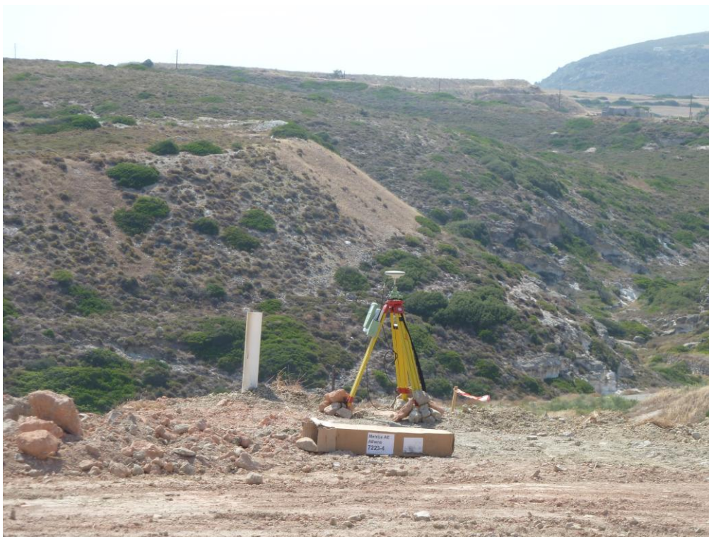
Σχήμα 4.14. Σταθμός βάσης διαφορικού GPS Leica πραγματικού χρόνου.
