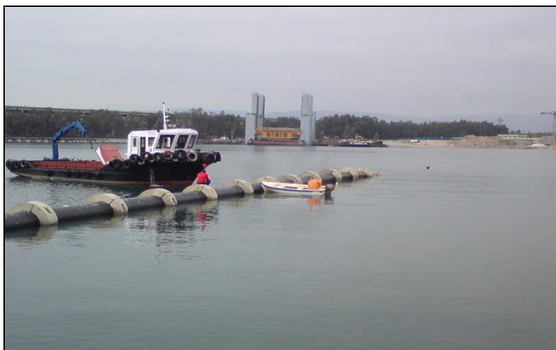
Εικόνα 3.6.(α) Πόντιση των αγωγών διάθεσης (πηγή: Αρχείο Βιολογικού Καθαρισμού Θριασίου Πεδίου)
