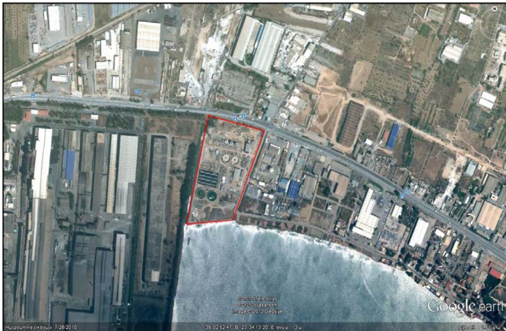
Εικόνα 3.2 Τοποθεσία Βιολογικού Καθαρισμού (πηγή: www.googleearth.com )
