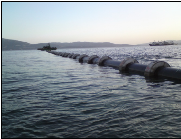
Εικόνα 1.6 Αγωγοί διάθεσης λυμάτων (Αρχείο Βιολογικού Καθαρισμού Ελευσίνας)
