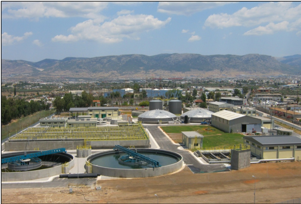
Εικόνα 3.1 Εγκαταστάσεις Βιολογικού Καθαρισμού (πηγή: Αρχείο Βιολογικού Καθαρισμού Θρασίου Πεδίου)
