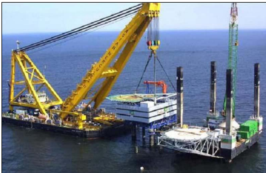
Εικόνα 1.5 Πλωτή εξέδρα για την διεκπεραίωση εργασιών θεμελίωσης ανεμογεννητριών (πηγή: http://www.nautilia.gr/ )
