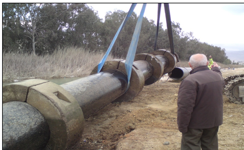
Εικόνα 3.6.(β) Πόντιση των αγωγών διάθεσης (πηγή: Αρχείο Βιολογικού Καθαρισμού Θριασίου Πεδίου)
