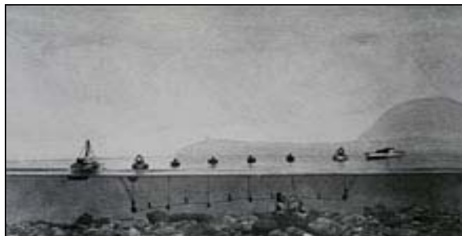
Εικόνα 2.10 Βυθομέτρηση με την μέθοδο των γριπίσεων (πηγή: http://celebrating200years.noaa.gov/ )
