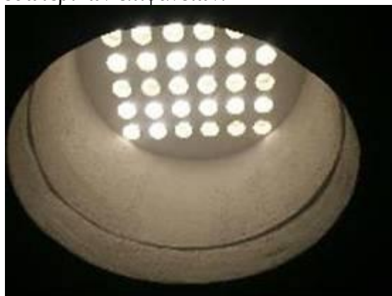
Εικόνα 2.4: Είσοδος φυσικού φωτισμού από θόλο. Πηγή: ΚΑΠΕ
