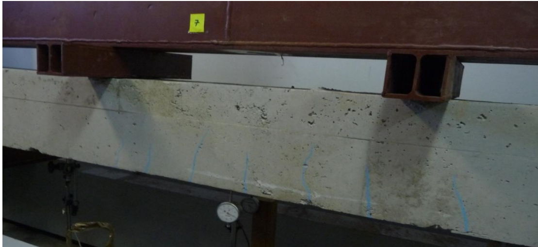
Σχήμα 4-14 Οι κύριες ρωγμές στη δοκό με σπλισμό χάλυβα
