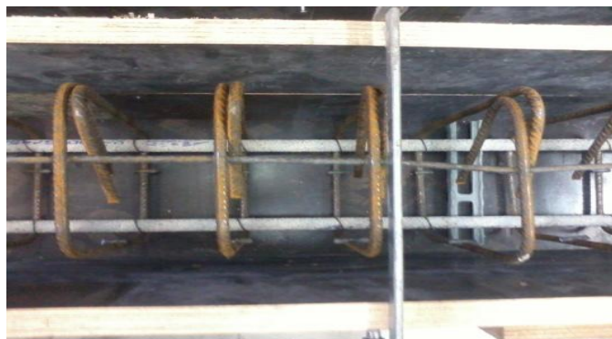
Σχήμα 4-3 Ο οπλισμός ράβδων G-FRP και ο διατμητικός οπλισμός
