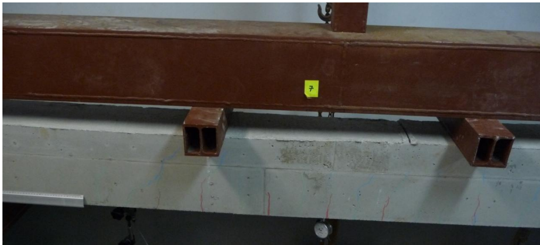
Σχήμα 4-13 Οι κύριες ρωγμές στη δοκό με οπλισμό G-FRP
