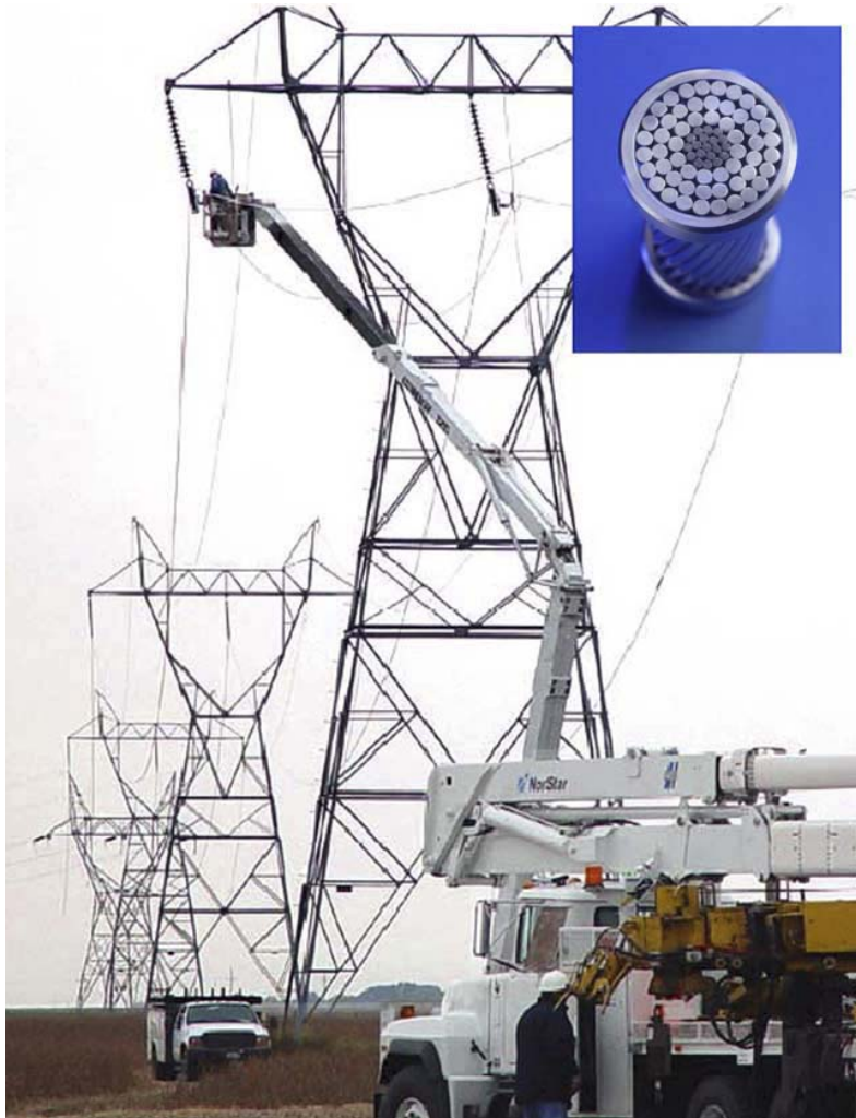
Εικόνα 2.3 Καλώδια διανομής ρεύματος από Al/Saffil MMC
