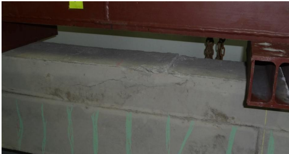
Σχήμα 4-15 Η θραύση στη δοκό με οπλισμό C-FRP
