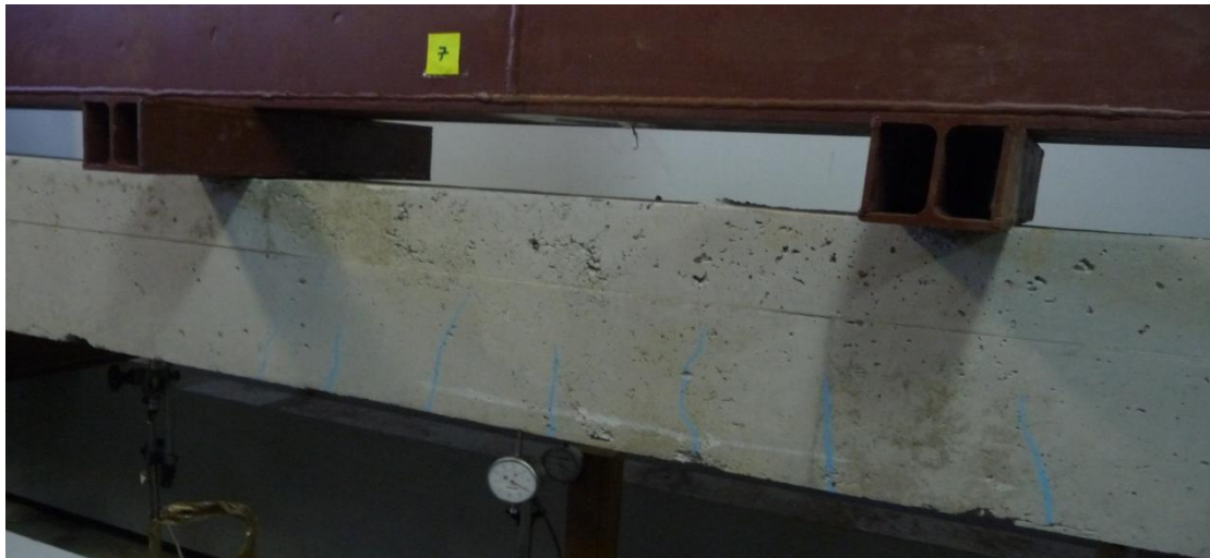
Σχήμα 4-14 Οι κύριες ρωγμές στη δοκό με οπλισμό χάλυβα
