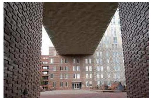
ΑΠΟΨΗ ΚΑΤΑ ΤΗΝ ΚΑΤΑΣΚΕΥΗ- ΑΠΟΨΗ ΕΣΩΤΕΡΙΚΟΥ ΑΙΘΡΙΟΥ
