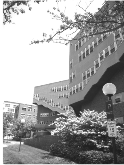
ΑΠΟΨΗ ΚΛΙΜΑΚΟΣΤΑΣΙΩΝ ΑΠΟ ΕΞΩ
