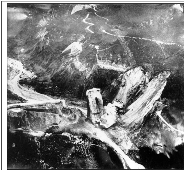
Σχήμα 2.3 Το φράγμα του St. Francis μετά την αστοχία. Πηγή: Courtesy of the Santa Clarita Valley Historical Society .
