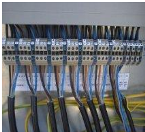
Κλέμες σύνδεσης παροχών Inverter με NY 4x4mm 2
