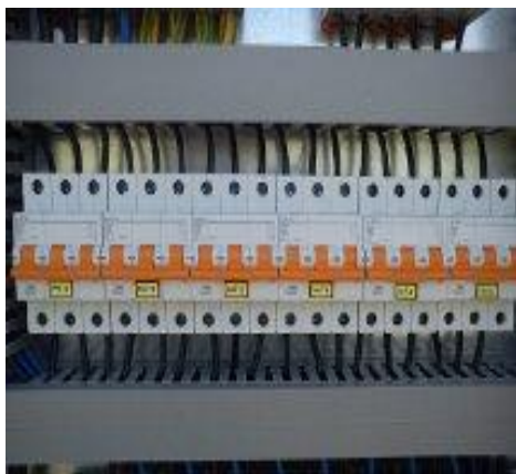
Μικραυτόματι 25A για τους inverter
