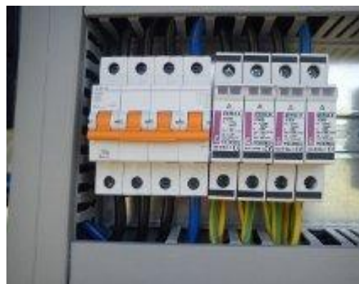
Τετραπολικός μικροαυτόματος, αντικεραυνικά AC
