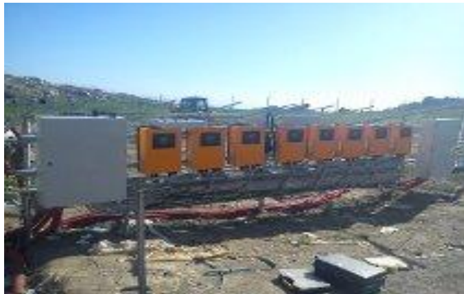
Σχ.3.9 : Διάταξη inverter με το γενικό πίνακα
