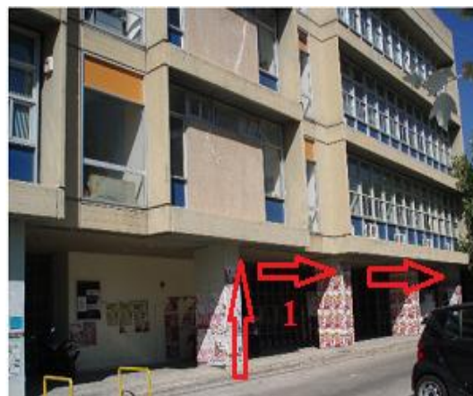
Εικόνα 3.4: Νότια όψη του Κτηρίου «Ε»
