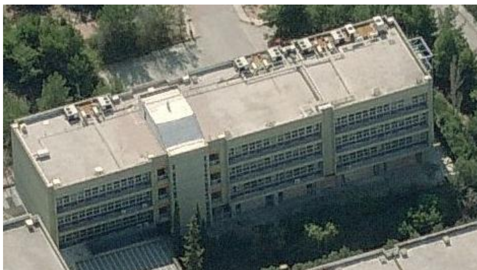
Εικόνα 3.1: Κτήριο «Ε» του Συγκροτήματος Γενικών Εδρών
