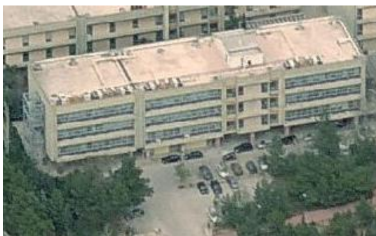
Εικόνα 3.5: Αεροφωτογραφία από Bing-Νότια όψη του Κτηρίου «Ε» (πρόσοψη)
