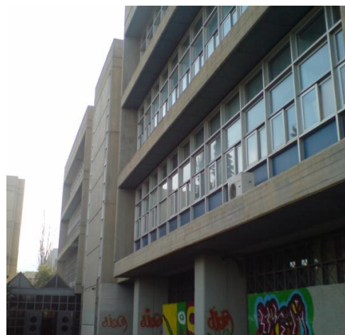
Εικόνα 3.6: Βόρεια όψη Κτηρίου «Ε»
