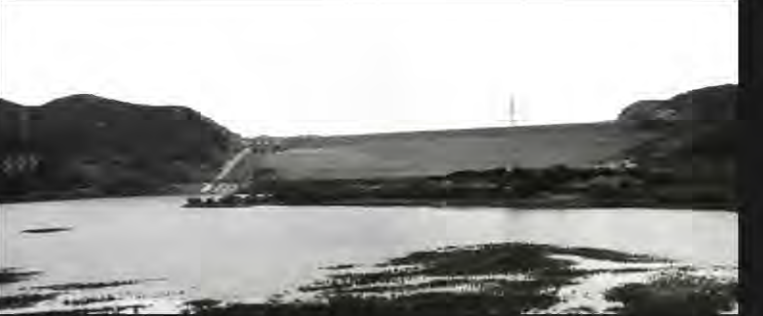
Φράγμα Πουρνάρι Η ταμειυτήρας : 26 500 στο χωρητικότητα : 350.000.000 km 3
