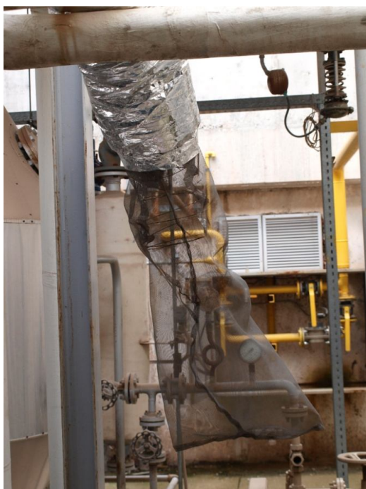
1.Εισαγωγή ατμοσφαιρικού αέρα
