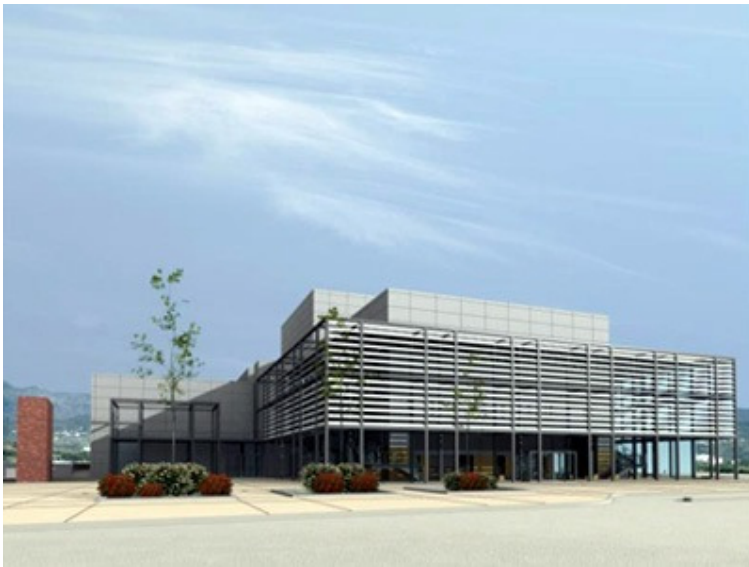
Εικόνα 5: Κατασκευή μεγάρου χορού
