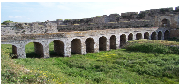
Εικόνα 16: Γέφυρα στη θέση Αγ.Πολύκαρπος
