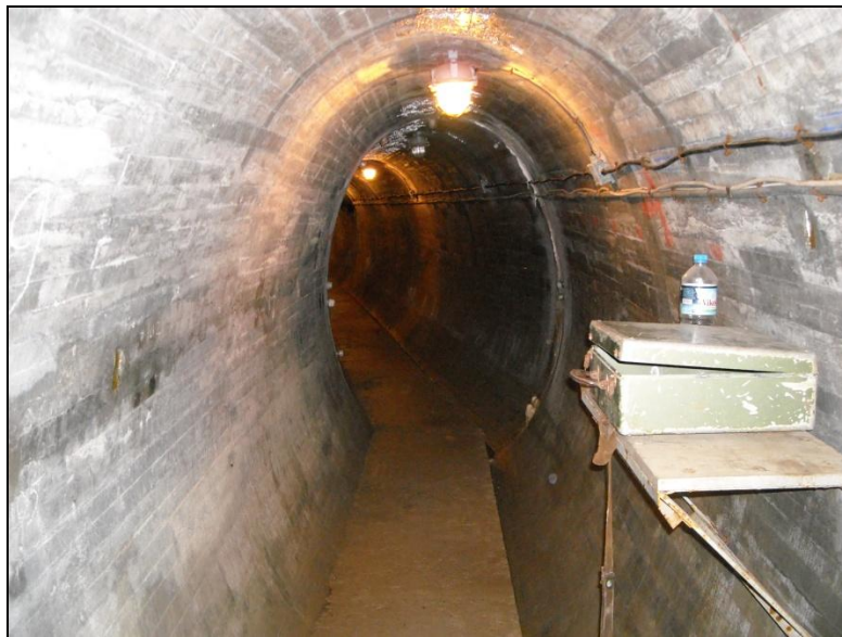
Εικόνα 11: Στοά για μετρήσεις εκκρεμών. Image 11: Gallery for pendulums measurements.
