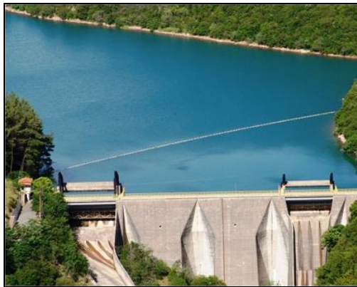
Εικόνα 1: Φράγμα από σκυρόδεμα (τύπου βαρύτητας) στο Λάδωνα ποταμό [27].
