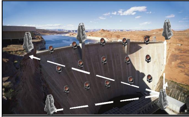
Εικόνα 10: Δίκτυο στόχων στο σώμα φράγματος [17].
