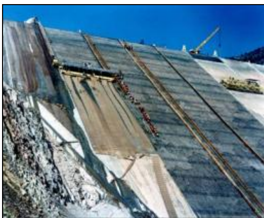
Εικόνα 5: Λιθόρριπτο φράγμα στην περιοχή Ραμπεντώσας με πλάκα επένδυσης από σκυρόδεμα (αντιπλημμυρικό φράγμα) [27].
