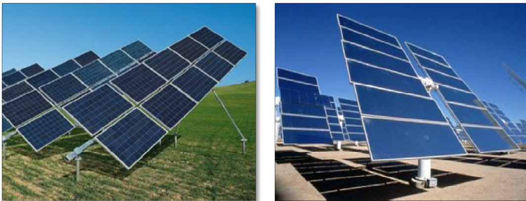
Εικόνα 6 και Ζ: Φωτοβολταϊκά πάρκα, φωτοβολταϊκά συστήματα σε ηλιοστάτη Πηγή: Ενεργειακό Γραφείο Κυπρίων πολιτών
