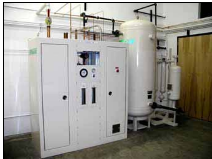
Σχήμα 1.24: Το σύστημα ανάκτησης ηλίου της Praxair που εγκαταστάθηκε στο σύστημα ψυχρού ψεκασμού της εταιρείας Ktech [Blöse et al. 2003].
