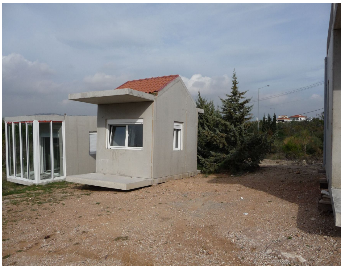
Εικόνα 10.3 Σύστημα άμεσου κέρδους-νότιο υαλοστάσιο
