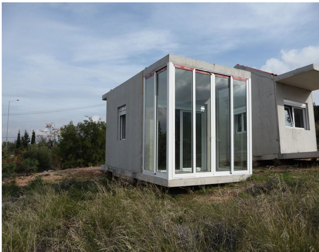
Εικόνα 10.1 Σύστημα ηλιακού χώρου, τύπου θερμοκηπίου
