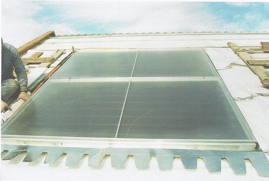
Εικόνα 3.7. Εγκατάσταση ηλιακού συστήματος θέρμανσης νερού στη δομή της στέγης
