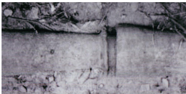
Σχήμα 1.4 Λεπτομέρεια σύνδεσης των πηλοσωλήνων (Mays 2006b)
