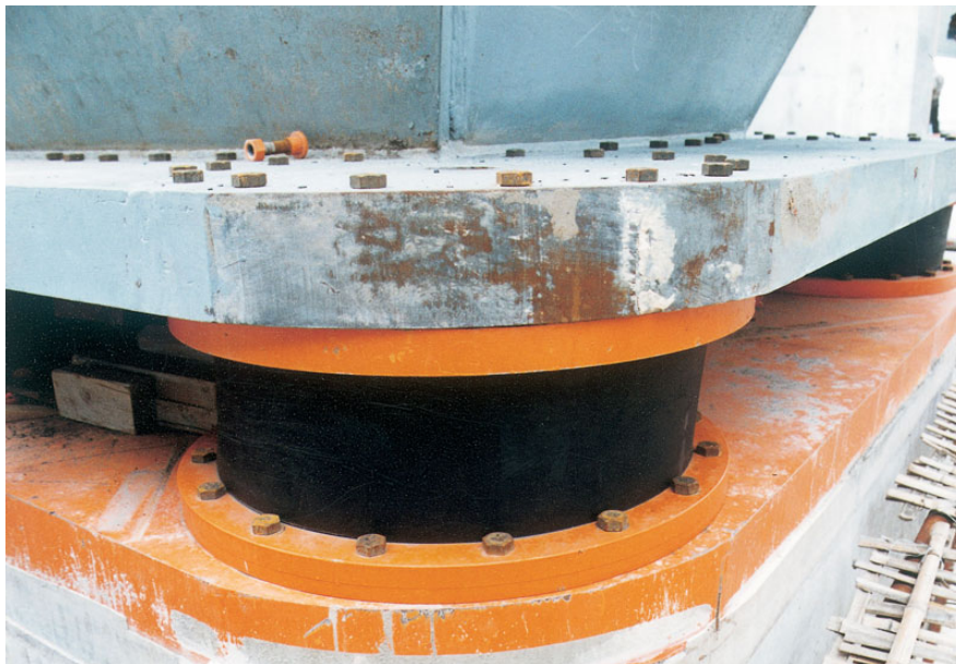
Σχήμα 2.10 Εφέδρανο LRB
