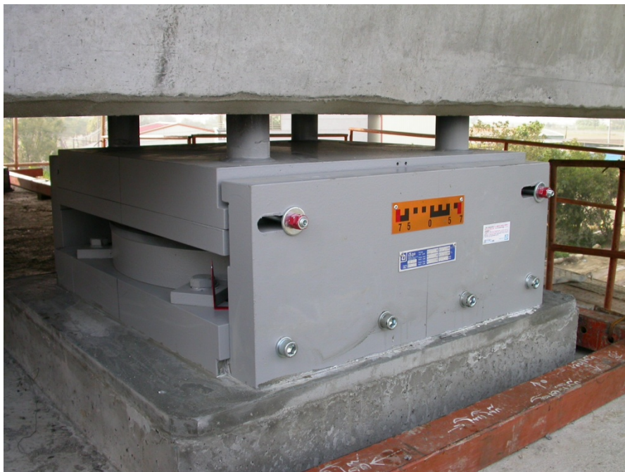
Σχήμα 1.3 Εφέδρανο Τριβής
