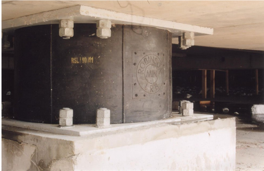
Σχήμα 1.2 Ελαστομεταλλικό Εφέδρανο
